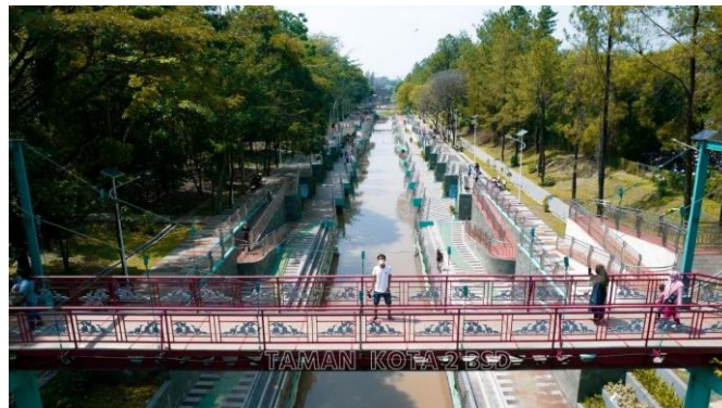
Gambar 5.3 Pembangunan Kali di Taman Kota 2
