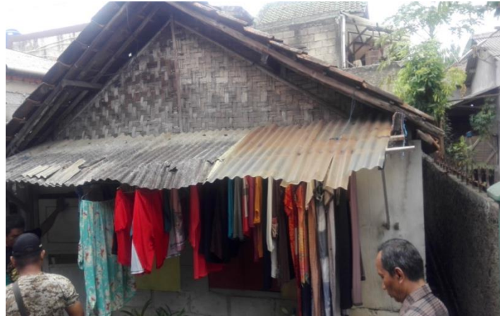
Gambar 4.5 RTLH Sebelum Direhab dan Setelah Direhab Di Kelurahan Parung Serab Tahun 2018/2019
