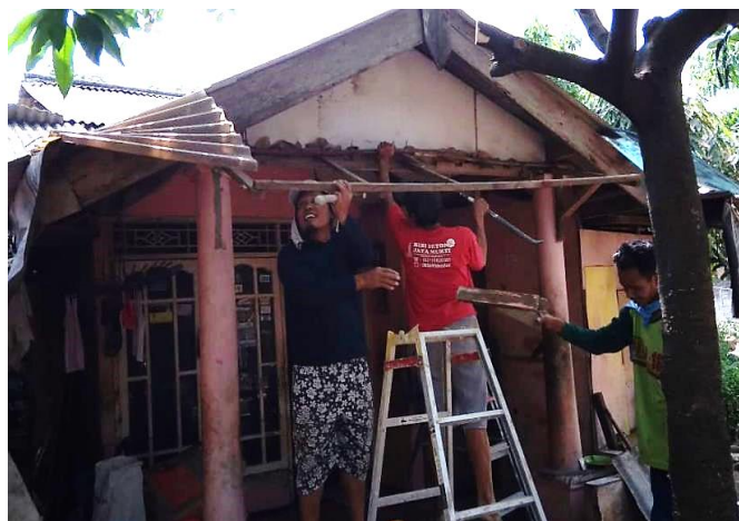
Gambar 4.3 Kondisi Bangunan Rumah Kumuh Pada Kelurahan Parung Serab
