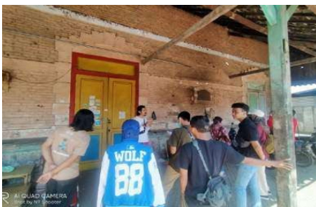
Gambar 5. Kegiatan survey dan observasi pada bangunan peninggalan colonial (Stasiun KA Parakan) oleh Tim Mahasiswa didampingi oleh NPL dan PIPPA
