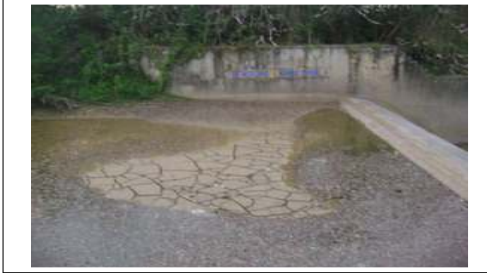
Gambar 10. Bendungan Langkowala di Kecamatan Lantari Jaya pada musim kemarau
