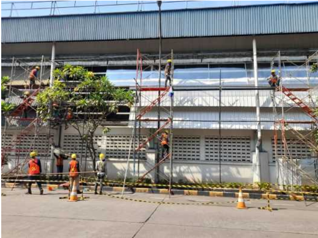
Gambar Lampiran 3 Aktivitas survey lapangan proyek penggantian atap kanopi gedung B engine PT Astra Honda Motor Pegangsaan
