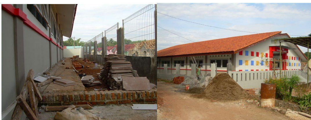
Gambar5. Proses pelaksanaan pembangunan Sekolah Dasar Fastabiquil Khoirot
