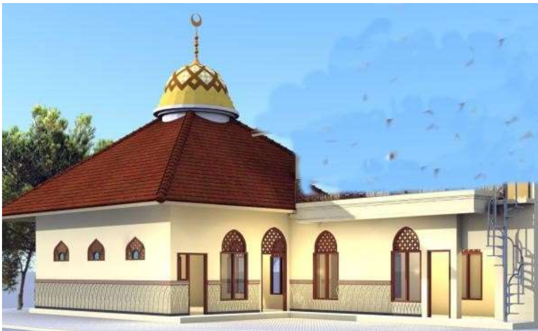
Gambar 12: Suasana Masjid at-taubah setelah di renovasi (Dokument DKM (at-Taubah)
