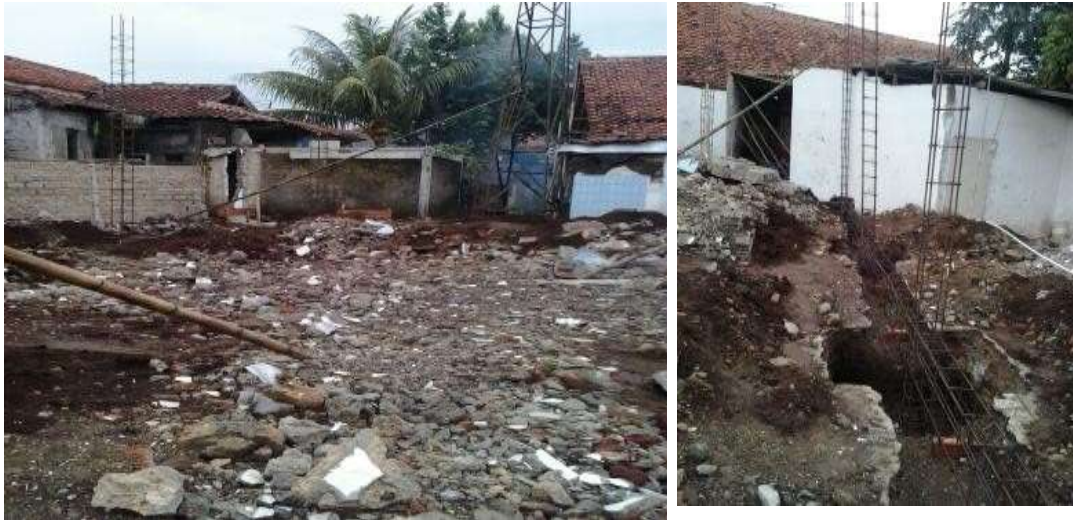
Gambar 11: Suasana peroses renovasi Musholah at-Taubah untuk menjadi Masjid (Dokument DKM at-Taubah)
