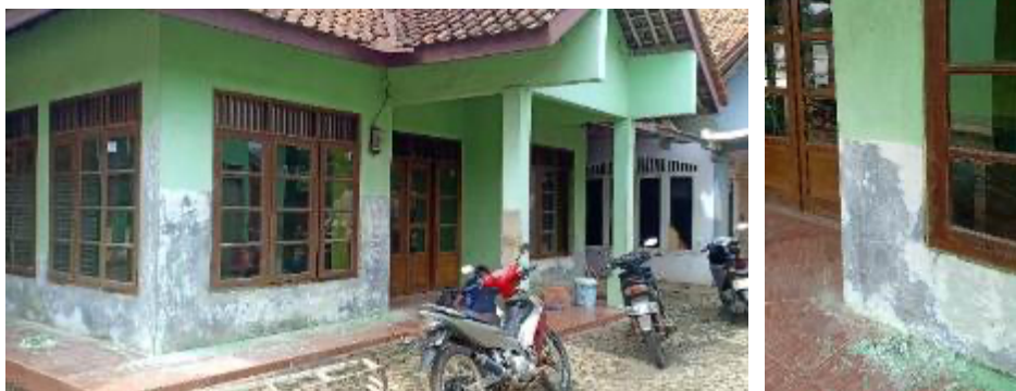
Gambar 7. Pengerokkan Cat Dinding Lama (Sumber: Dokumentasi, April 2020)
