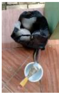
Gambar 9. Bahan dan Alat untuk Pekerjaan Plamir Tembok (Sumber: Dokumentasi, April 2020)
