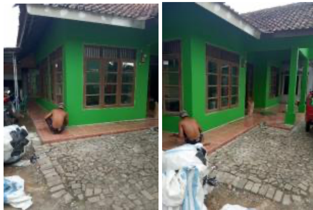
Gambar 10. Pengecatan Dinding dan Penggantian Lisplang (Sumber: Dokumentasi, April 2020)
