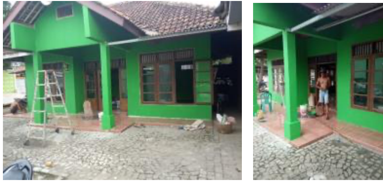
Gambar 11. Pengecatan Dinding Eksterior (Sumber: Dokumentasi, April 2020)
