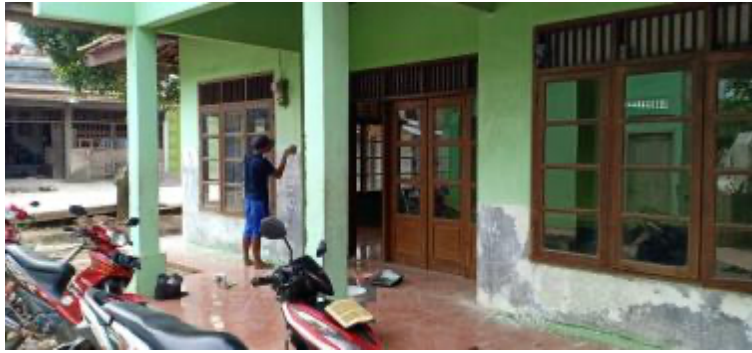
Gambar 8. Pekerjaan Plamir Tembok (Sumber: Dokumentasi, April 2020)
