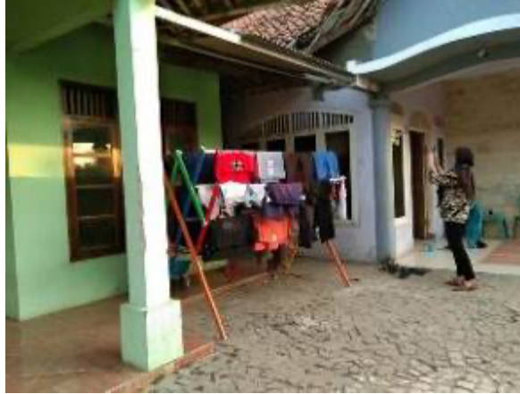
Gambar 3. Penataan Luar Majelis yang Belum Tertata dengan Baik (Sumber: Dokumentasi, Juli 2019)
