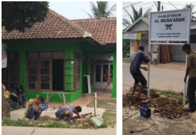
Gambar 12. Penggalian Tanah untuk Pondasi dan Pemasangan Papan Nama (Sumber: Dokumentasi, Agustus 2020)
