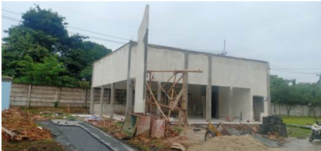
Gambar 1. Pembangunan Mushola Al-Abror Sumber: Dokumentasi, Januari 2021
