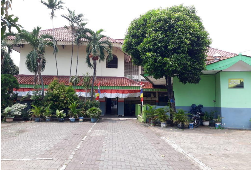
Gambar 7 Gedung SDN Kembangan Selatan 03
