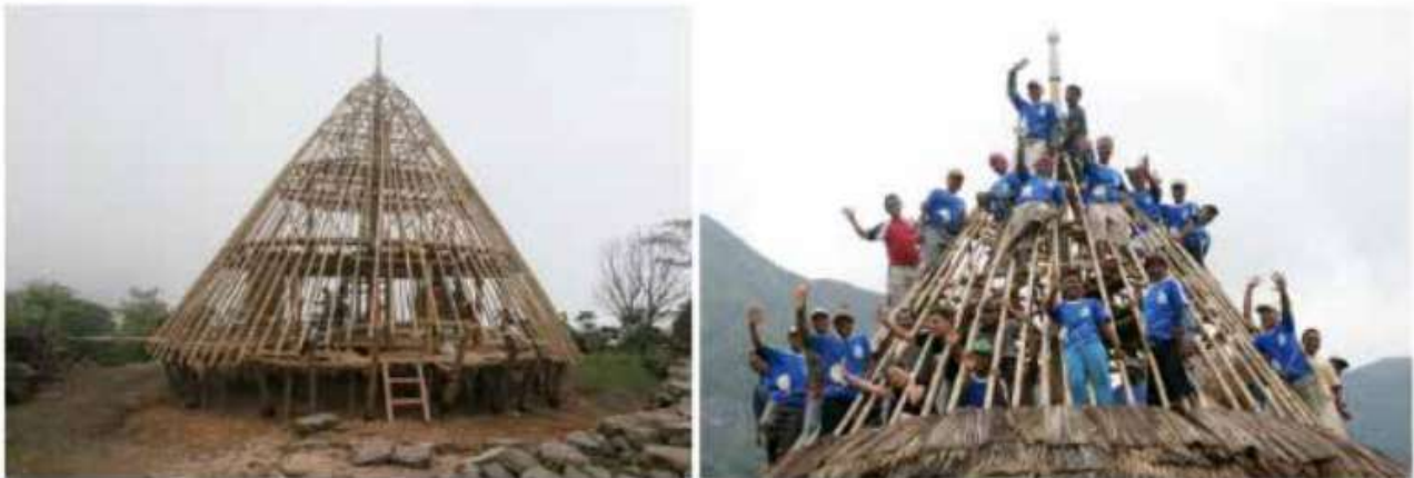
Gambar 90 Proses Pembangunan Mbaru Niang Wae Rebo Sumber: rumahasuh.co.id
