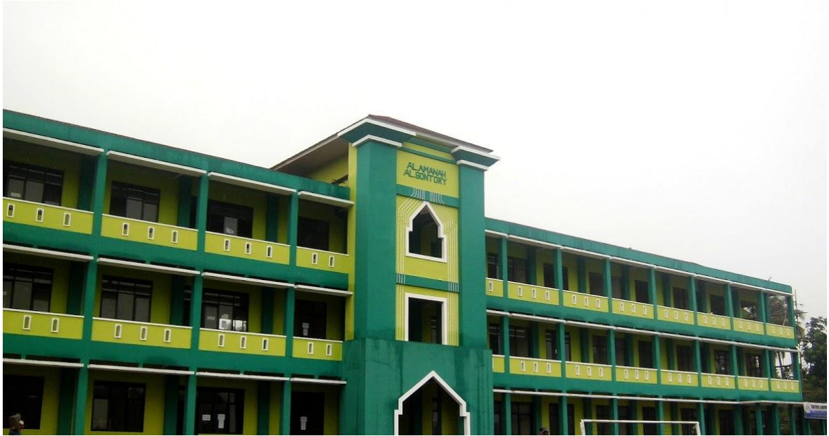
Gedung Sekolah Pondok Pesantren Al Amanah Al Gontory Putra
