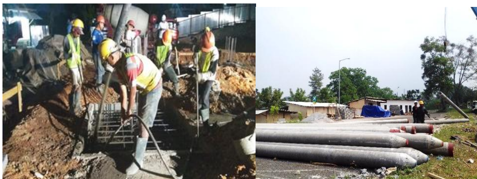
Gambar 7. Proses Pembuatan Pondasi Pada Bagian Pilecap Dengan Metode Konvensional Sumber: itb.ac.id, 2020
