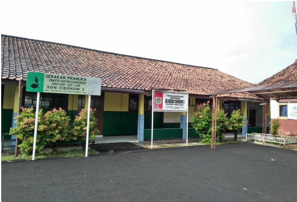
Gambar Gedung SDN Cidokom 03 Bogor
