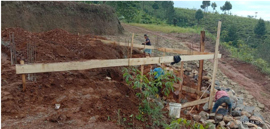
Pembangunan Masjid untuk SMK N 1 Pandanarum
