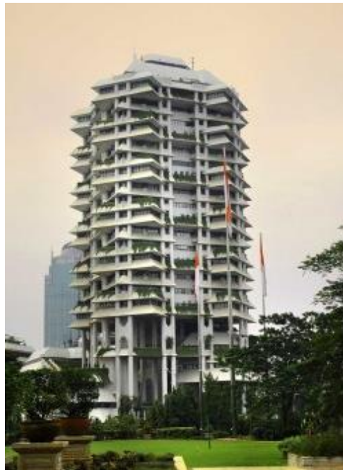
Gambar 2.6 Gedung Wisma Dharmala Sakti.
