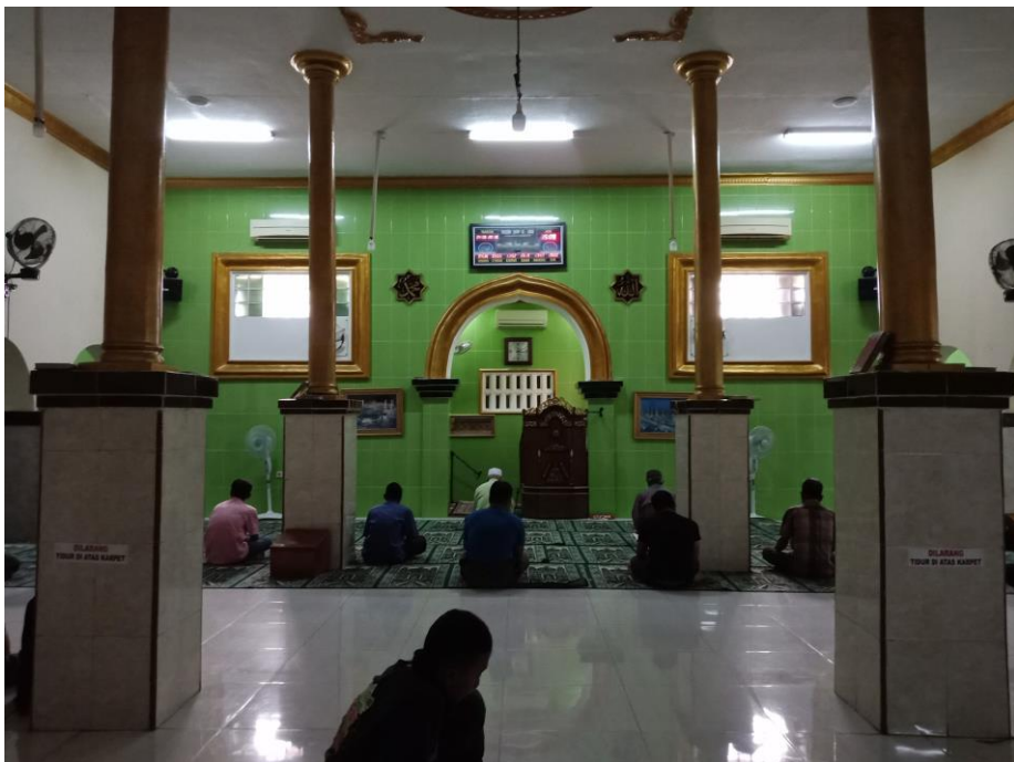
Gambar 4.43 Interior Ruang Utama Shalat Jama'ah Kaum Pria Masjid Al Arif. Terlihat empat tiang saka guru yang sudah diganti dengan struktur beton. [Dokumentasi Penulis, 2018].
