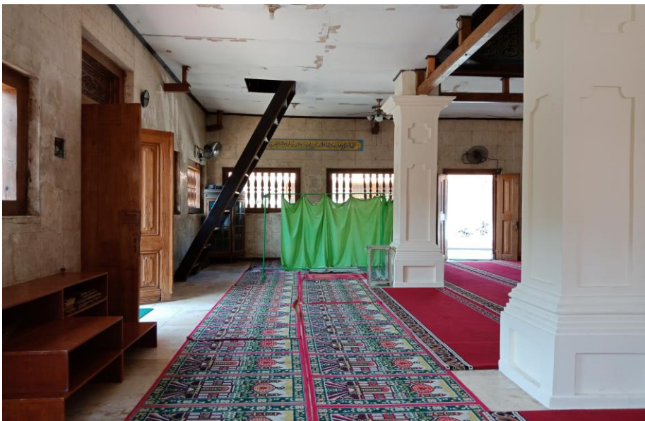
Gambar 5.74 Interior Ruang Utama Masjid Angke. Tampak konstruksi tangga kayu untuk naik ke loteng [Dokumentasi Penulis, 2018].
