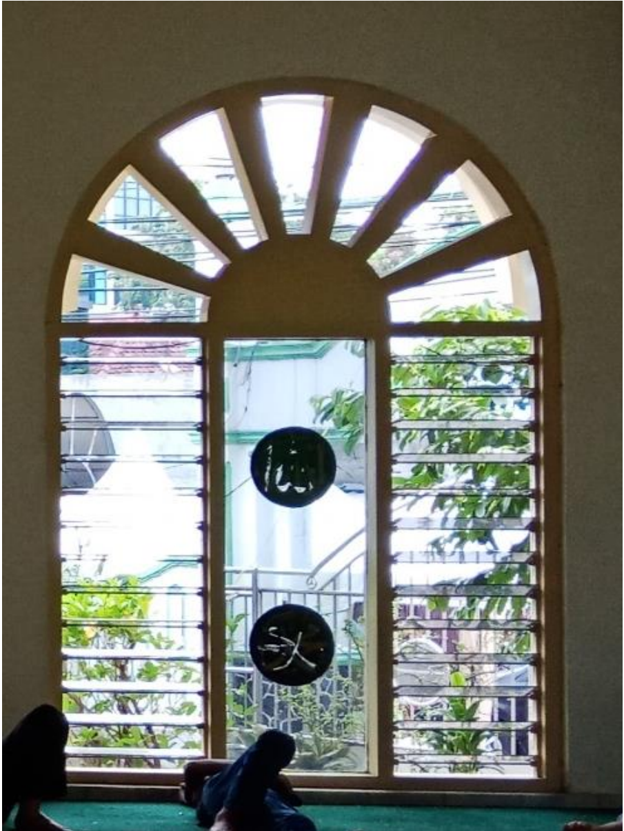
Gambar 6.31 Detail Bentuk dan Konstruksi Jendela Kaca Krepyak Masjid Matraman. [Dokumentasi Penulis, 2018].
