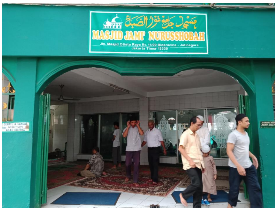
Gambar 6.39 Tempat Depan Teras Selatan Masjid Nurushobah. Yang juga sebagai gerbang masuk utama. [Dokumentasi Penulis, 2018].
