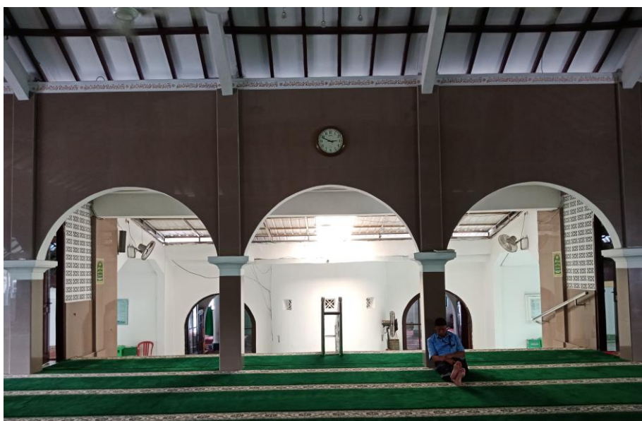
Gambar 6.60 Lubang Pada Dinding Sisi Timur Ruang Utama Bangunan Baru Masjid Al Ma'mur. [Dokumentasi Penulis, 2018].
