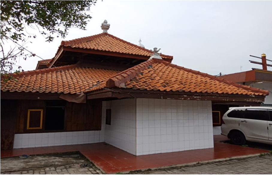
Gambar 3.3 Masjid Al Alam Cilincing, Bangunan Lama. [Dokumentasi Penulis, 2018].
