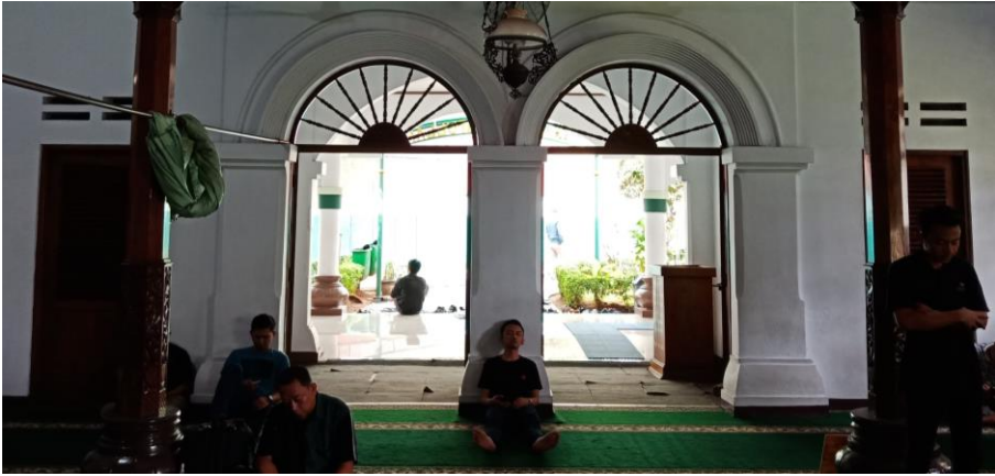
Gambar 7.3 Pintu Sisi Timur (Interior) Ruang Utama Masjid Hidayatullah. [Dokumentasi Penulis, 2018].
