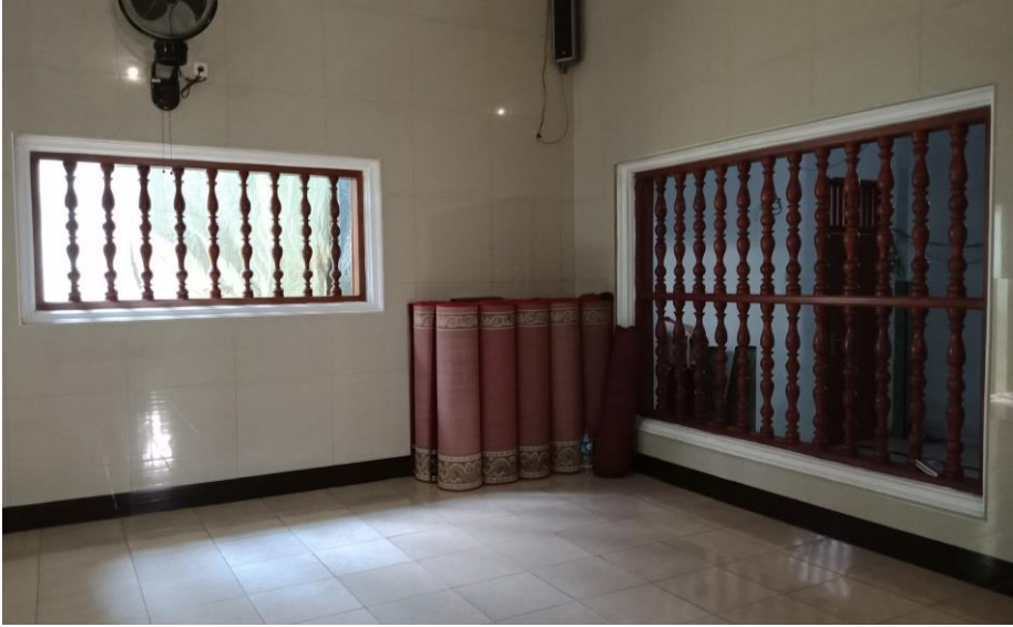
Gambar 4.36 Konstruksi Jendela dengan Jalusi Kayu Masjid Al Anshor, Bangunan Lama. Bentuk konstruksi jendela ini merupakan salah satu ciri khas Jendela Bangunan Betawi. [Dokumentasi Penulis, 2018].
