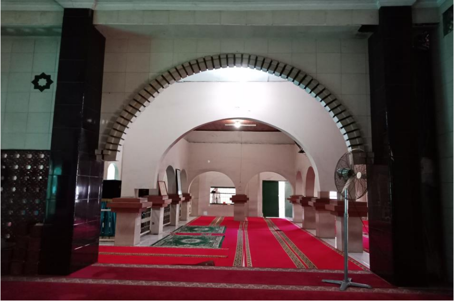
Gambar 5.113 Lubang Lengkungan Setengah Lingkaran yang menyatukan Ruang Utama Bangunan Lama dan Bangunan Baru Masjid Al Mukarromah. [Dokumentasi Penulis, 2018].
