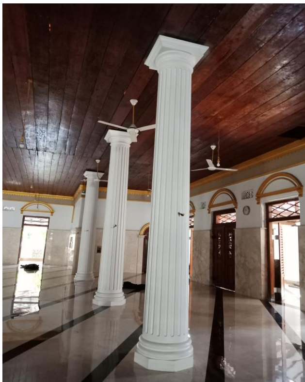
Gambar 5.55 Detail Pilar Masjid An Nawier. [Dokumentasi Penulis, 2018].
