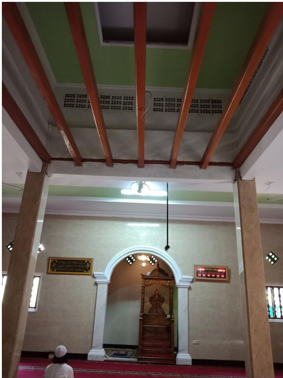
Gambar 4.35 Susunan Balok Berjejer Di bagian atas, di antara keempat tiang Saka Guru Masjid Al Anshor, Bangunan Lama. Bagian ini dianggap yang masih orisinil. [Dokumentasi Penulis, 2018].
