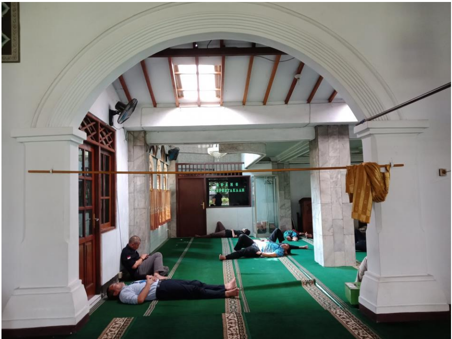
Gambar 7.5 Lubang Dinding Sisi Utara (Interior) Ruang Utama Masjid Hidayatullah. [Dokumentasi Penulis, 2018].
