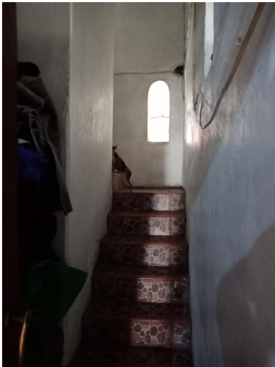
Gambar 5.60 Tangga naik ke atas pada bagian Dasar Bangunan Menara Masjid An Nawier. [Dokumentasi Penulis, 2018].
