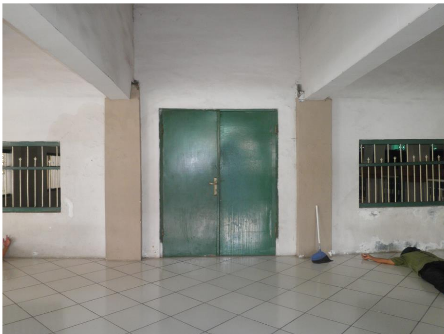
Gambar 5.110 Pintu dan Jendela Pada Bangunan Lama Masjid Al Mukarromah. Terlihat pintunya tenggelam karena adanya peninggian peil lantai.[Dokumentasi Penulis, 2018].
