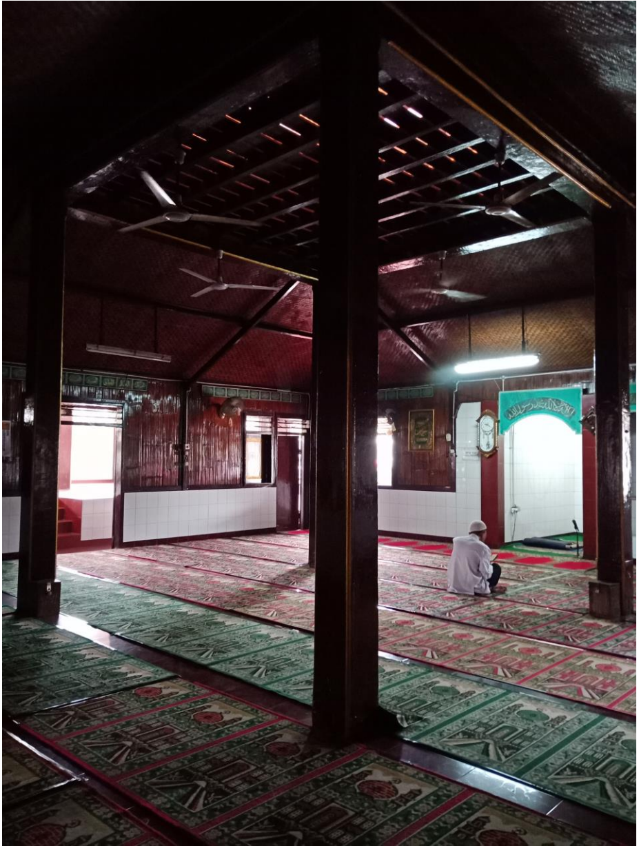
Gambar 3.5 Konstruksi Saka Guru Masjid AlAlam Cilincing, Bangunan Lama. Tampak pada bagian pamidhangan terdapat konstruksi susunan papan yang juga sebagai penutup ruangan bagian atas. Warna coklat tua mendominasi warna Ruang Shalat Utama ini. [Dokumentasi Penulis, 2018].
