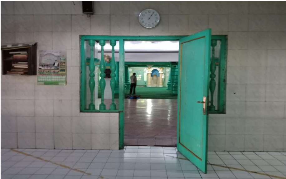
Gambar 5.22 Detail Pintu dan Jendela Masjid Al Mansyur. Terdapat pada dinding pemisah serambi timur bagian luar dan dalam; ia sebagai pintu masuk dari serambi timur bagian luar ke serambi timur bagian dalam. Bentuk dan Konstruksinya khas Betawi. [Dokumentasi Penulis, 2018].
