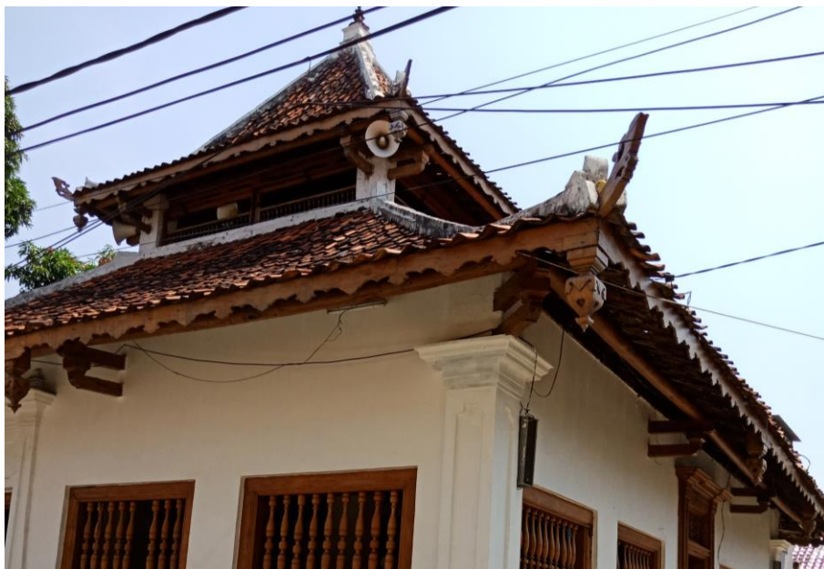
Gambar 5.76 Konstruksi Konsol Bentuk Belalai Gajah Tumpuk pada Atap Masjid Angke. Ciri khas konstruksi pada Bangunan Tradisional Tionghoa (Cina) [Dokumentasi Penulis, 2018].
