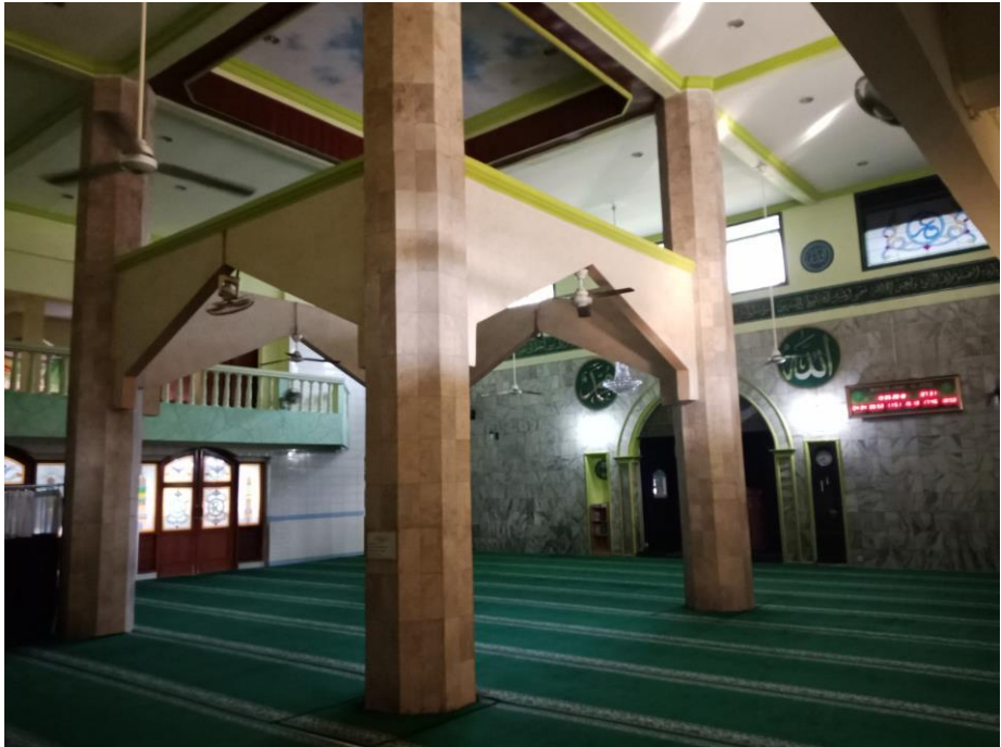
Gambar 4.23 Interior Ruang Dalam Masjid Al Atiq. Terlihat Struktur empat kolom beton penyangga atap. [Dokumentasi Penulis, 2018].
