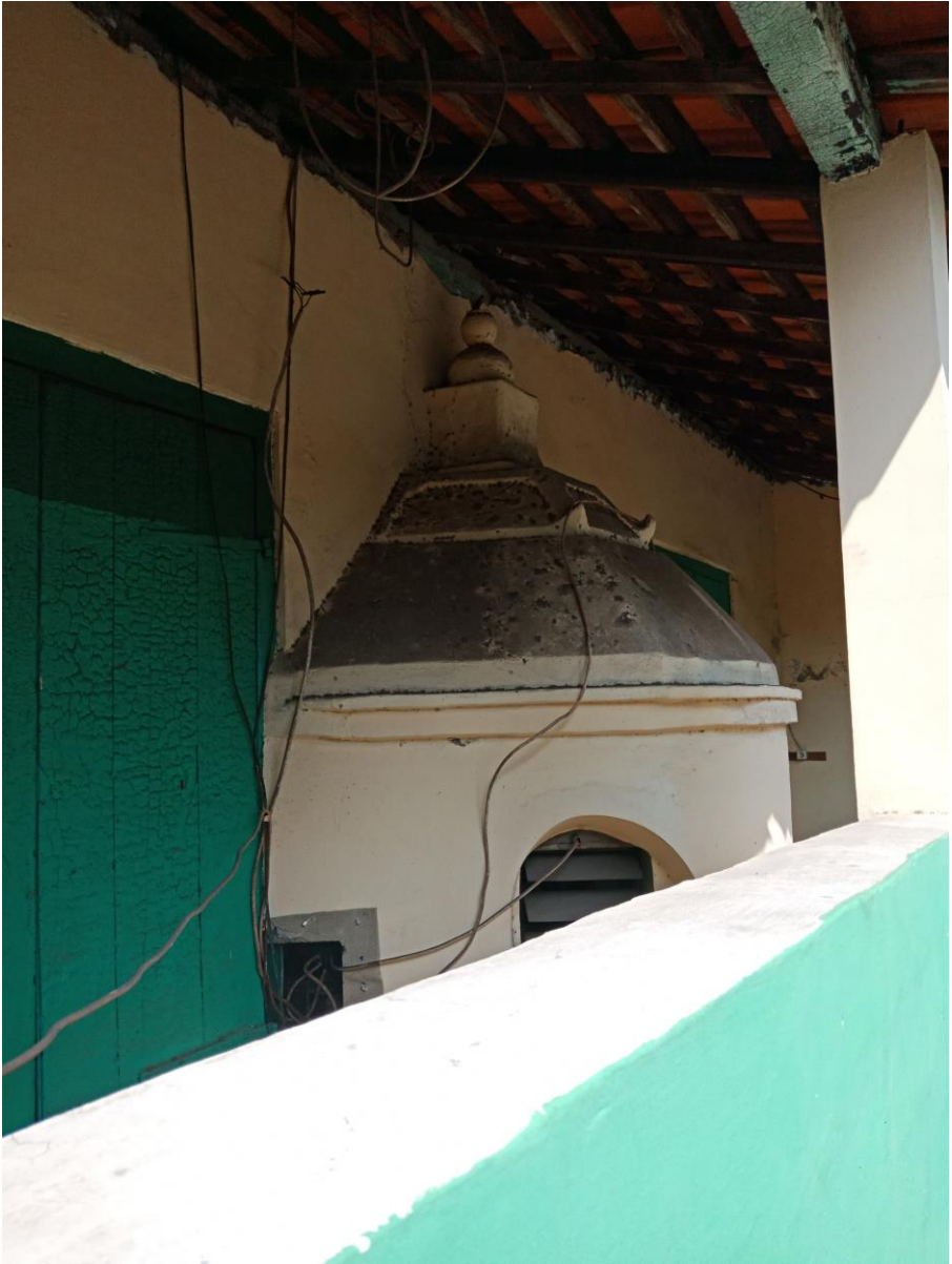
Gambar 6.71 Eksterior Mihrab Masjid Ar Raudah. Nampak pada bagian atas penutup atapnya berupa memolo atau mustaka . [Dokumentasi Penulis, 2018].
