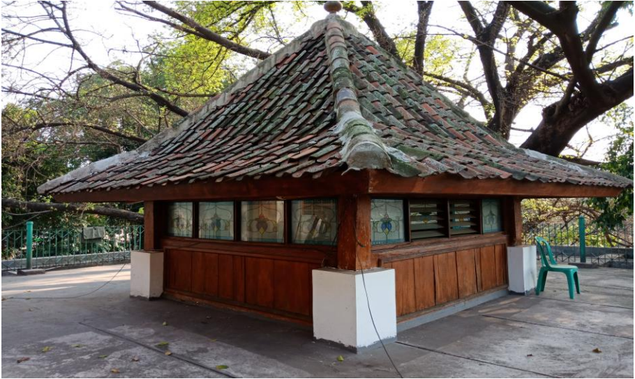
Gambar 4.2 Bentuk Awal Masjid Jami' As Salafiyah Jatinegara Kaum. Berukuran sekitar 4m x 4m beratap tajuk dengan konstruksi saka guru . Kondisi sekarang, konstruksi atap ini berada di atas atap dak bangunan hasil renovasi. [Dokumentasi Penulis, 2018].
