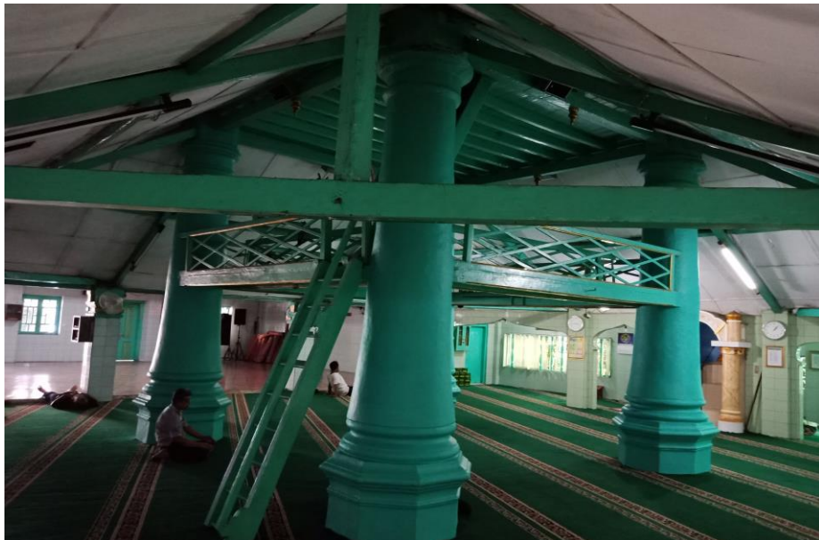
Gambar 5.10 Interior Ruang Dalam (Ruang Utama Shalat) Masjid Al Mansyur. Nampak konstruksi Saka Guru berbahan batu, berbentuk Order Dorik Yunani. Terlihat pula konstruksi tangga untuk menuju Loteng. [Dokumentasi Penulis, 2018].
