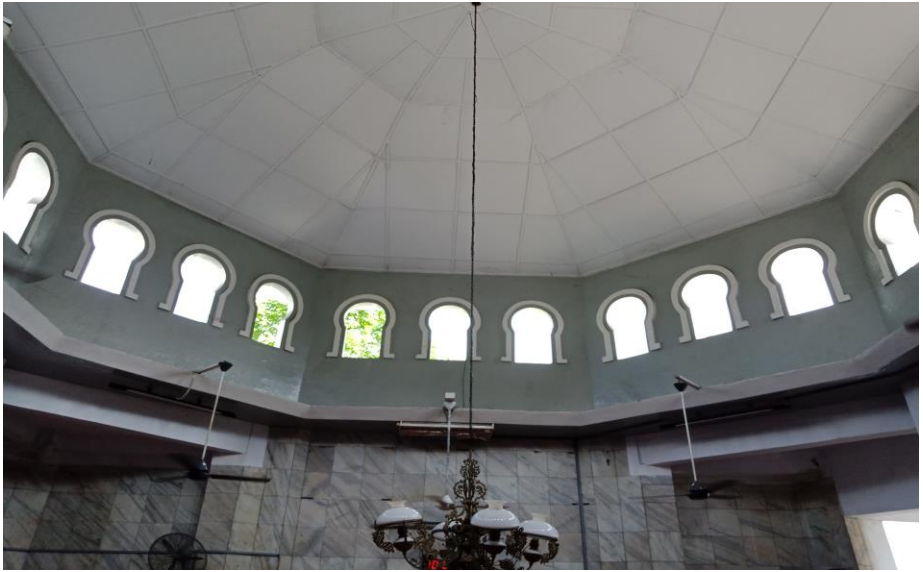
Gambar 5.102 Lubang Angin di bagian atas Ruang Utama (Baru) Masjid Jami' Kebon Jeruk, yang berbentuk Segi Delapan [Dokumentasi Penulis, 2018].
