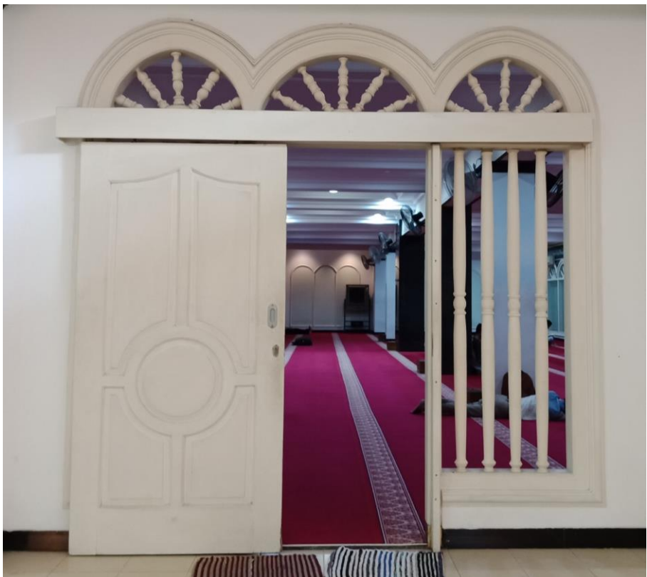
Gambar 6.85 Detail Bentuk dan Konstruksi Pintu Jendela (Jenis Pintu Geser) Ruang Utama Bangunan Baru Masjid Nurul Abrar. [Dokumentasi Penulis, 2018].
