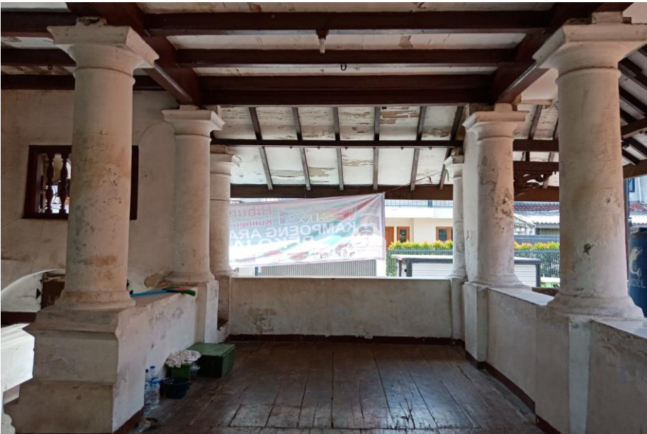
Gambar 6.26 Serambi Luar Masjid Langgar Tinggi. Kolom-kolomnya bergaya Klasik-Order Dorik Yunani [Dokumentasi Penulis, 2018].
