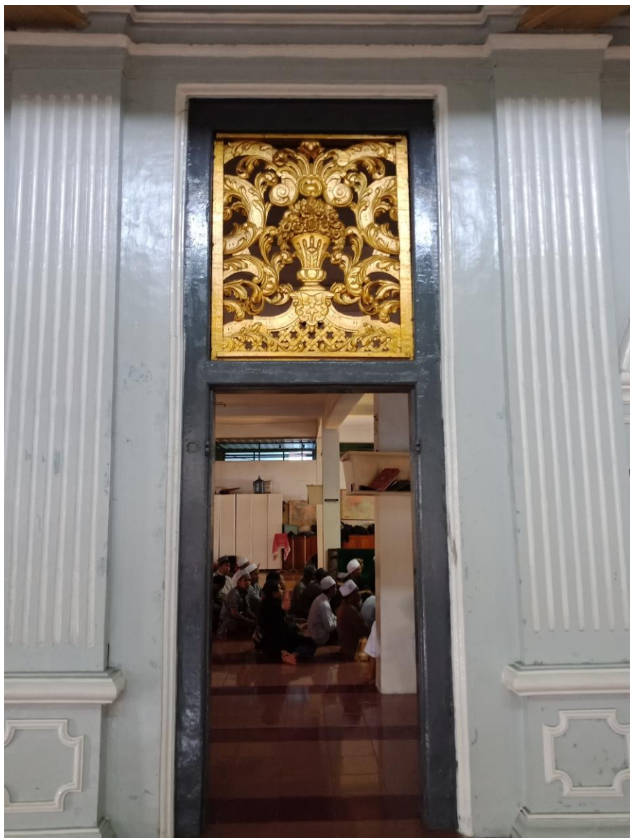
Gambar 5.99 Detail lubang Pintu (berupa Kusen Pintu) Masuk Sisi Timur Ruang Utama (Lama) Masjid Jami' Kebon Jeruk. Tampak hiasan indah pada bagian atas pintu yang mengingatkan pada seni budaya Jawa. [Dokumentasi Penulis, 2018].
