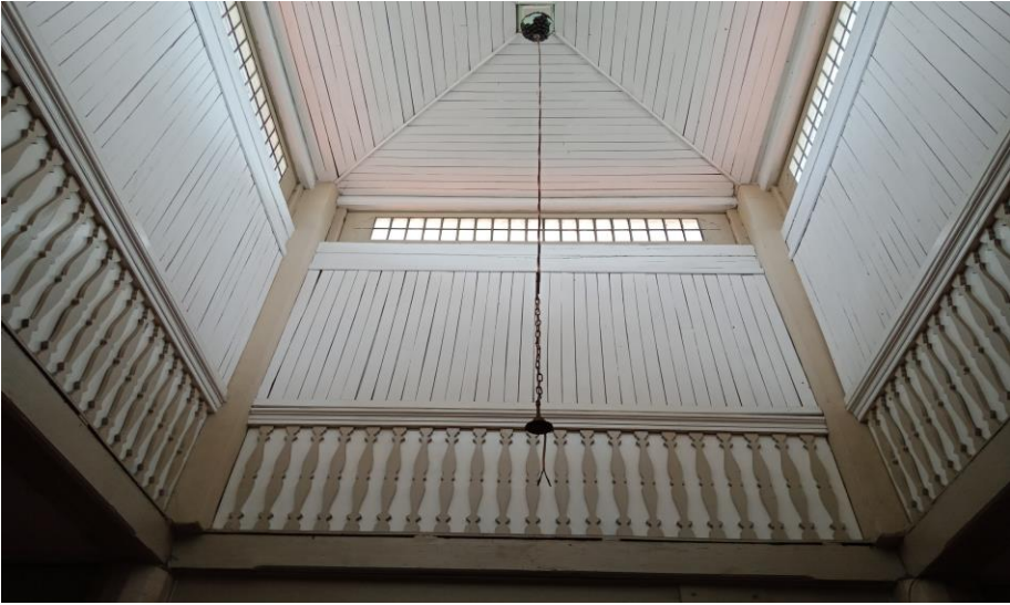
Gambar 5.45 Ruang bagian atas di antara keempat tiang saka guru Masjid Kampung Baru. Tertutupi oleh susunan papan kayu. Pada bagian bawah terdapat hiasan ornamen balustrade khas Betawi. [Dokumentasi Penulis, 2018].
