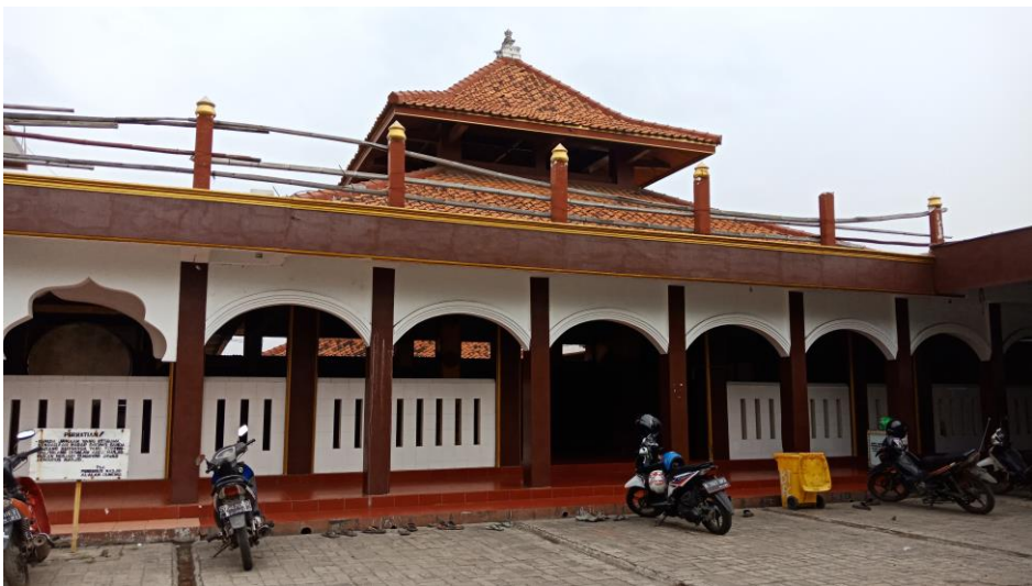
Gambar 3.12 Masjid Al alam Cilincing, Bangunan Baru (Serambi) sisi Timur. Bentuk atap tajuk tumpang dua dan lengkungan berulang mendominasi tampilan bangunan. [Dokumentasi Penulis, 2018].
