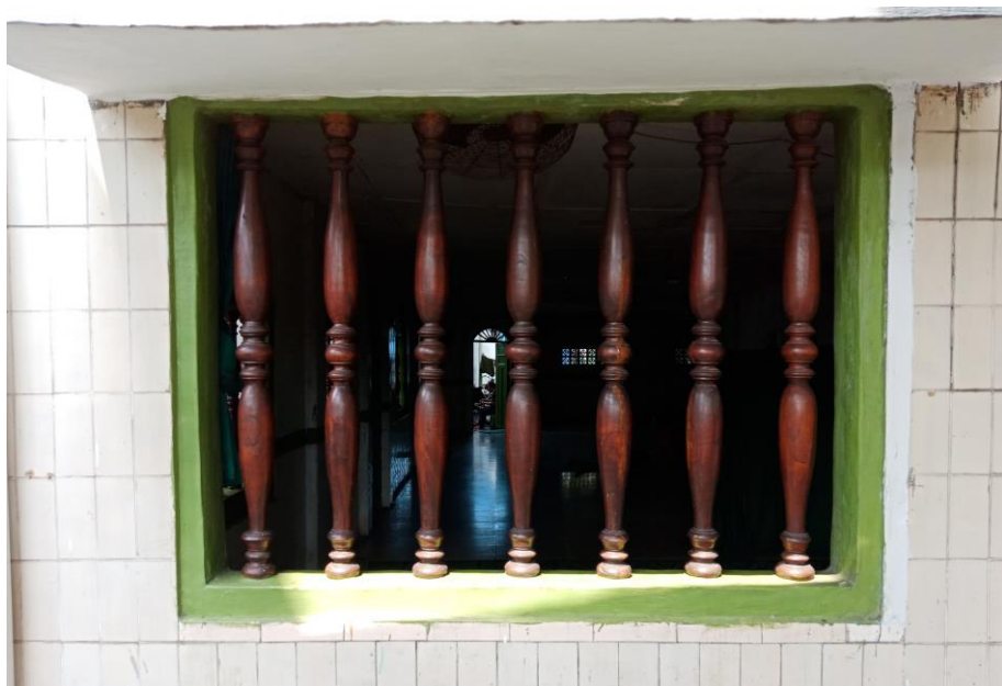
Gambar 5.48 Detail Bentuk dan Konstruksi Jendela Masjid Kampung Baru. Bentuk jalusinya unik bulat berukir: khas Betawi. [Dokumentasi Penulis, 2018].
