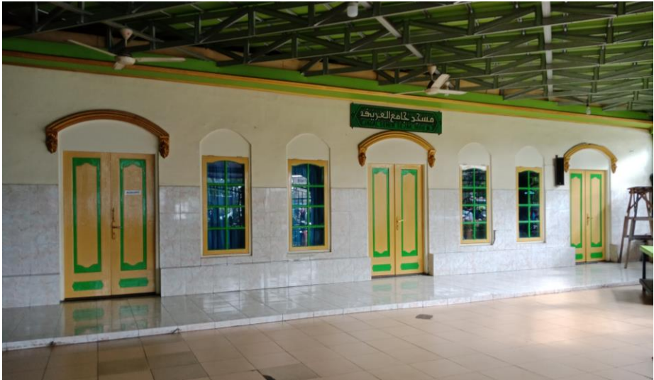
Gambar 4.52 Tampilan Pintu dan Jendela Bangunan Masjid Al Arif. [Dokumentasi Penulis, 2018].
