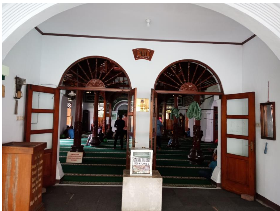
Gambar 7.2 Pintu Sisi Timur (Eksterior) Ruang Utama Masjid Hidayatullah. [Dokumentasi Penulis, 2018].
