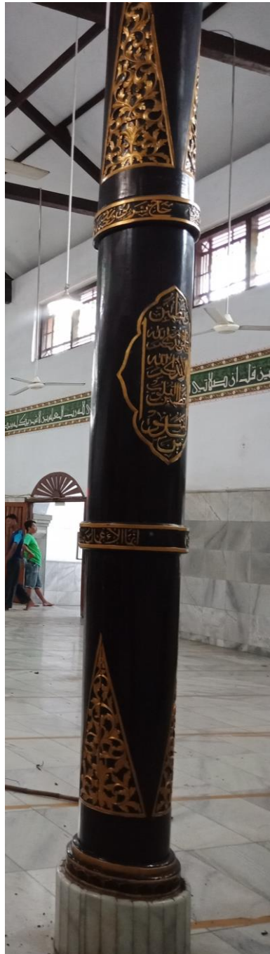
Gambar 6.3 Detail tiang di Ruang Utama Masjid At Taibin. [Dokumentasi Penulis, 2018].
