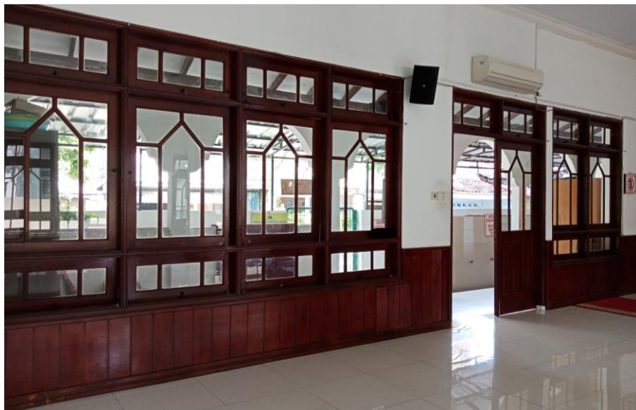
Gambar 6.13 Bentuk dan Konstruksi Pintu dan Jendela sisi Selatan Ruang Utama Masjid Az Zawiyah. [Dokumentasi Penulis, 2018].
