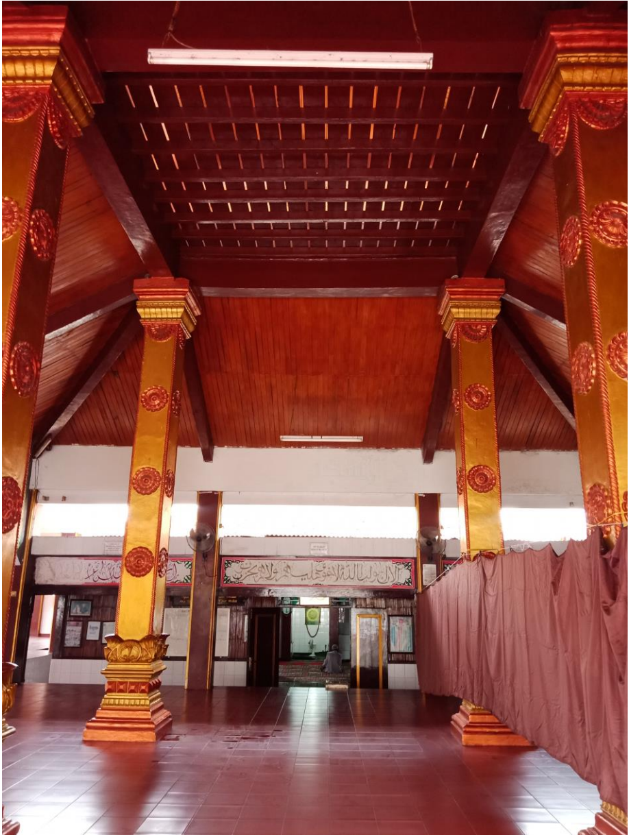
Gambar 3.13 Konstruksi Saka Guru Masjid Al alam Cilincing, Bangunan Baru Sisi Timur (dijadikan Serambi masjid). Tampak pada keempat tiangnya terdapat hiasan ornamen. [Dokumentasi Penulis, 2018].
