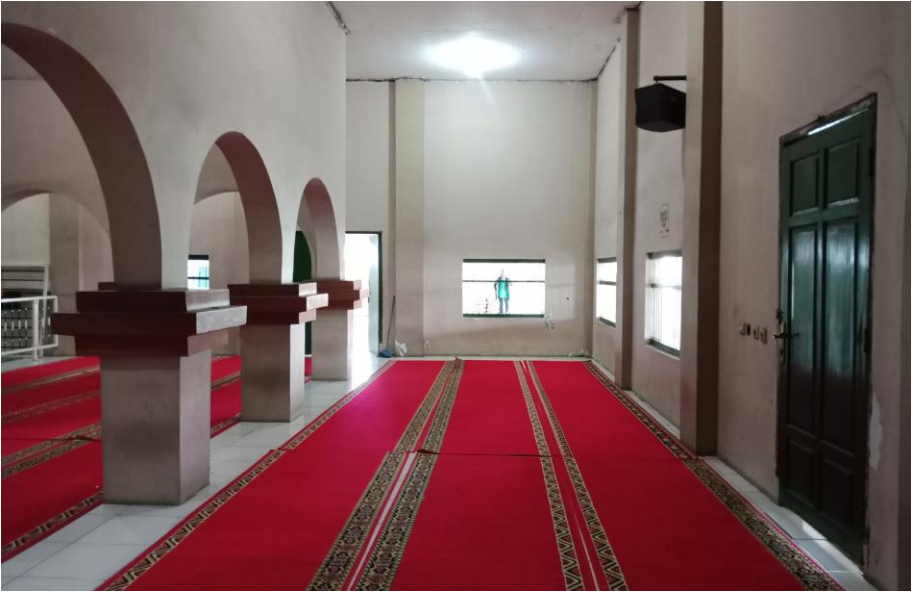
Gambar 5.108 Serambi Dalam Selatan Bangunan Lama Masjid Al Mukarromah. [Dokumentasi Penulis, 2018].
