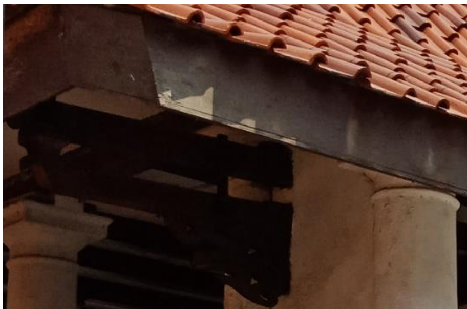
Gambar 6.27 Konstruksi konsol pada Serambi Luar Masjid Langgar Tinggi. Bentuknya siku tumpuk yang merupakan ciri khas konstruksi pada bangunan tradisional Tionghoa. [Dokumentasi Penulis, 2018].
