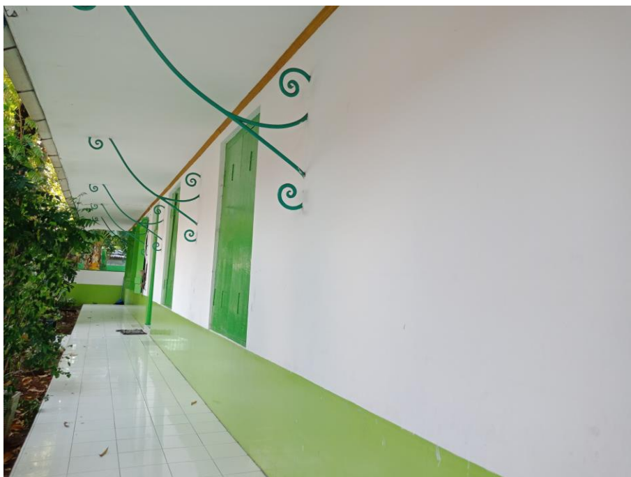
Gambar 6.72 Teras Selatan Masjid Ar Raudah. Nampak kosol teras bahan plat besi berbentuk lengkungan indah. [Dokumentasi Penulis, 2018].
