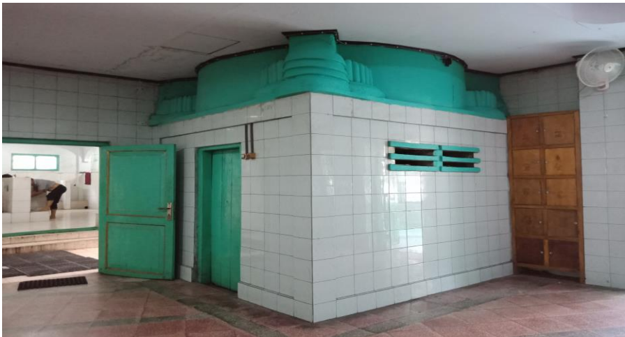
Gambar 5.19 Bagian Bawah Bangunan Menara Masjid Al Mansyur. Terdapat pintu masuk ke dalam bangunan Menara. [Dokumentasi Penulis, 2018].
