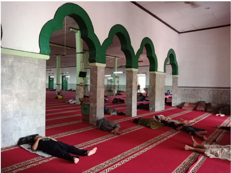
Gambar 5.3 Serambi Masjid Al Ma'mur. Pada pembatas ruang serambi dan ruang utama terdapat lubang-lubang masuk yang masing-masingnya pada bagian atas berbentuk tiga lengkungan seperti kelopak daun. [Dokumentasi Penulis, 2018].
