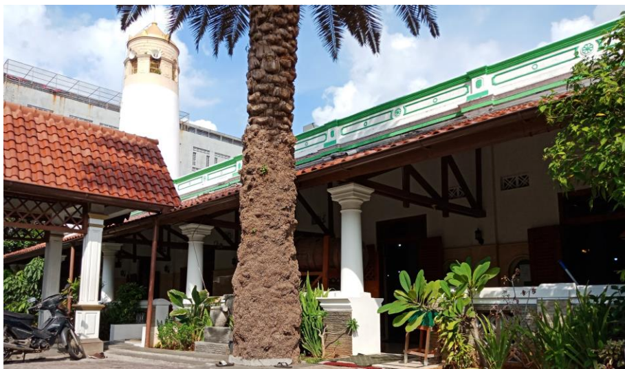
Gambar 5.62 Eksterior Serambi Utara Masjid An Nawier. Tampak Hiasan Menarik pada Lisplank atau Entablature [Dokumentasi Penulis, 2018].
