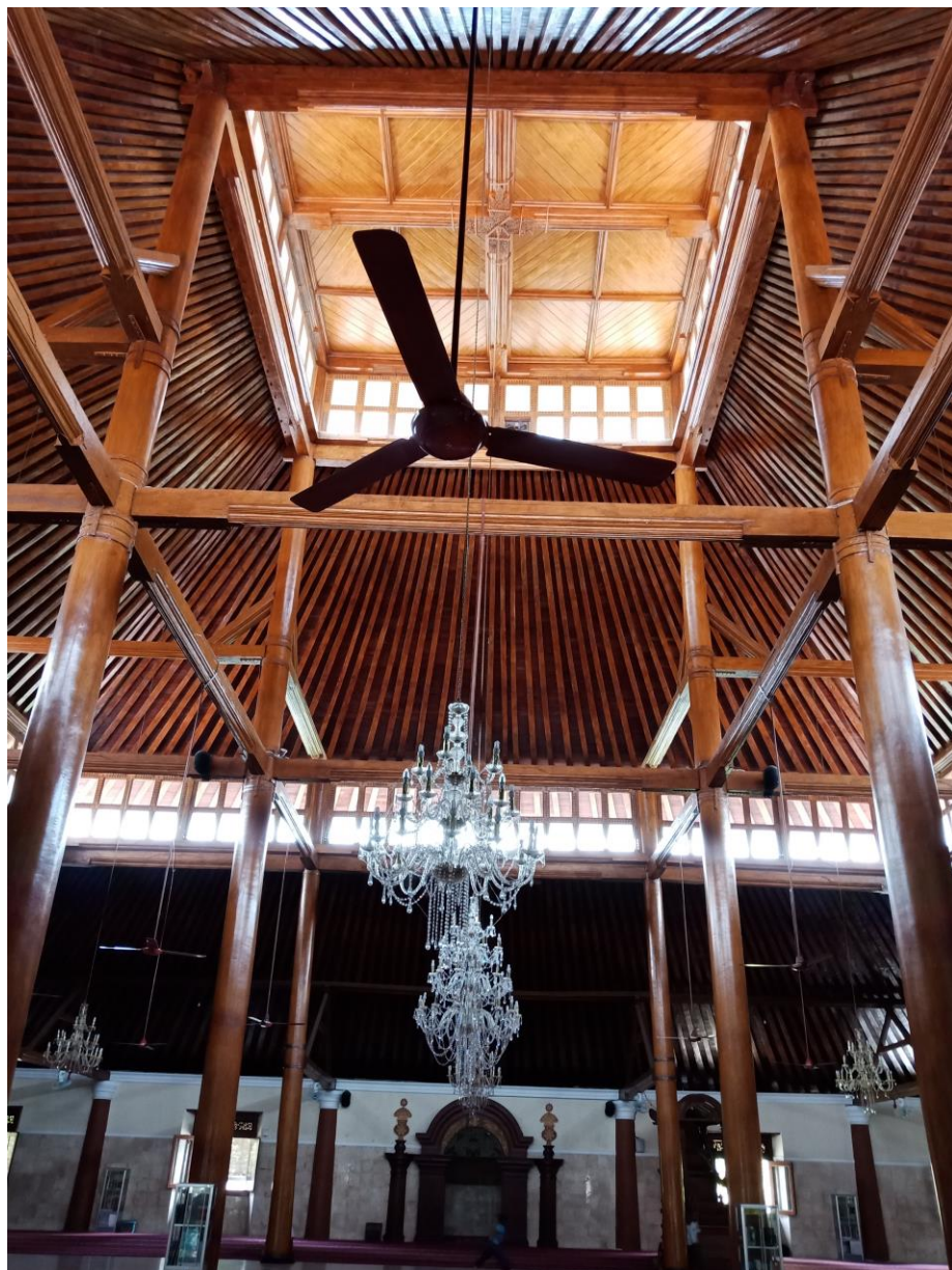
Gambar 7.22 Struktur dan Konstruksi Soko Guru Masjid Agung Surakarta (Tim Eksplorasi, 2018).
