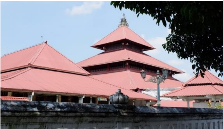
Gambar 3.4 Bentuk atap Masjid Gedhe Kauman Yogyakarta; kiri adalah serambi bentuk atap limasan susun dua, tengah adalah bangunan utama bentuk atap tajuk susun tiga dengan mahkota besar, kanan adalah tempat wudlu pria bentuk atap tajuk susun dua dengan mahkota kecil.
