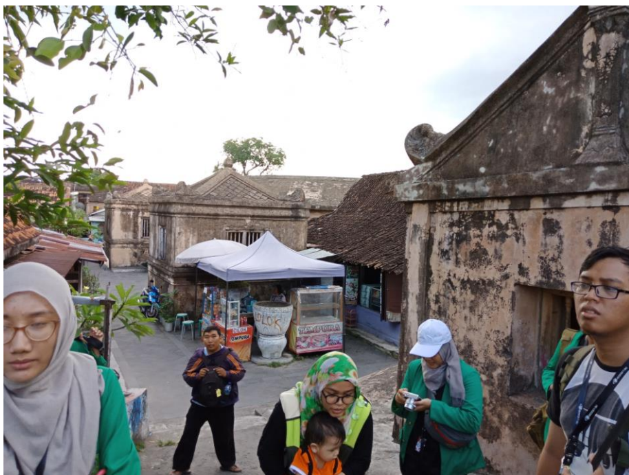
Gambar 4.23 Bangunan-bangunan “nongol” yang berfungsi untuk pencahayaan terowongan di bawahnya (Tim Eksplorasi, 2018)
