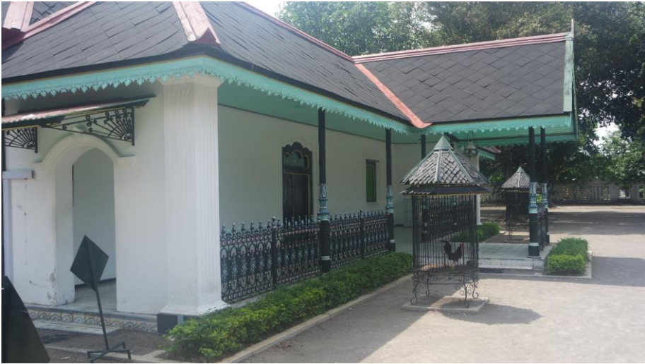
Gambar 2.10 Bangsas Angun-Angun . Bangunan ini difungsikan sebagai tempat penyimpanan senjata kerajaan. Atap bangunan ini berbentuk limasan yang berpenutup atap warna hitam. Pada bagian tritisan ada ukiran kayu yang dibentuk bergerigi pada ujungnya berwarna hijau toska. Tembok tingginya sekitar 3,5 meter dicat berwarna putih. Bentuk bangunannya persegi panjang. Namun ditambahkan teras yang menjulur ke depan pada bagian tengah bangunan, sehingga jika dilihat dari atas seperti berbentuk “T”. Pada bagian teras depan terdapat pagar kayu yang diukir sedemikian rupa yang letaknya di antara tiang-tiang. Di depan bangunan terdapat dua ayam jago dalam kandangnya masing-masing. (Tim Eksplorasi, 2018)
