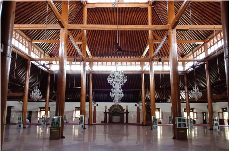
Gambar 7.21 Struktur dan Konstruksi Ruang Utama Masjid Agung Surakarta (Tim Eksplorasi, 2018).
