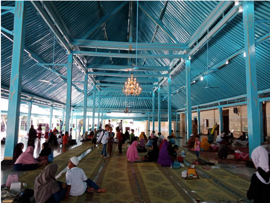
Gambar 7.13 Struktur dan konstruksi bangunan serambi masjid (Tim Eksplorasi, 2018).
