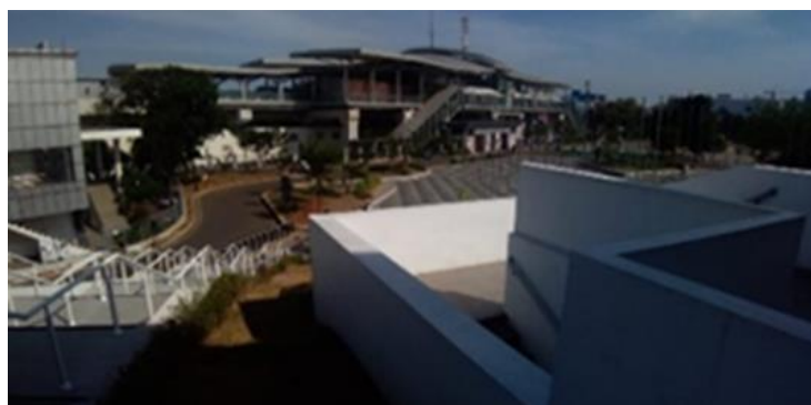
Gambar 2. Stasiun LRT Dekat Velodrome Sumber: Dokumentasi Pribadi, 2019
