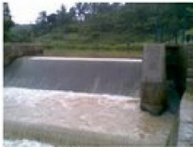
Dam mini / bendi-dam
