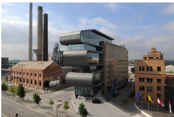
Gambar 6. Kantor Omnicore di Hooglebeek, Belgia. Tampak pada gambar bahwa bangunan extension sangat kontras dengan bangunan lain disekitarnya. Sumber : Lavinia (2011)
