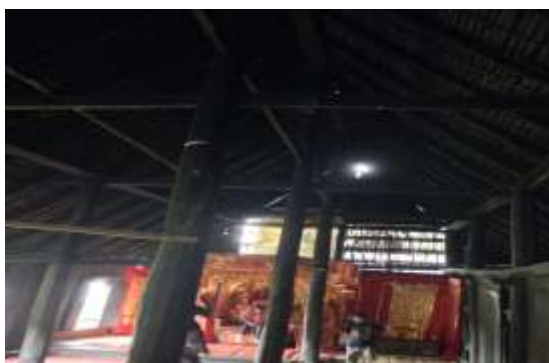
Gambar 4: Struktur rangka atap dan tiang-tiang di dalam Rumah Tuo Kampai Nan Panjang yang terlihat langsung karena tanpa penutup plafond (Sumber: dokumentasi pribadi, 2014)
