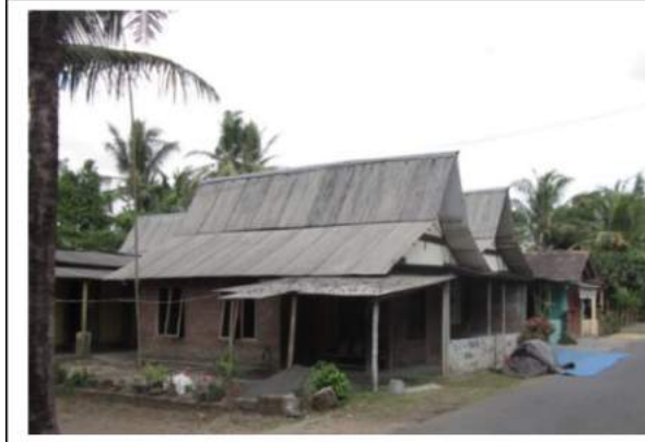
Gambar 5: Rumah penduduk yang mengalami penambahan ruang Sumber: Dokumentasi pribadi, 2012
