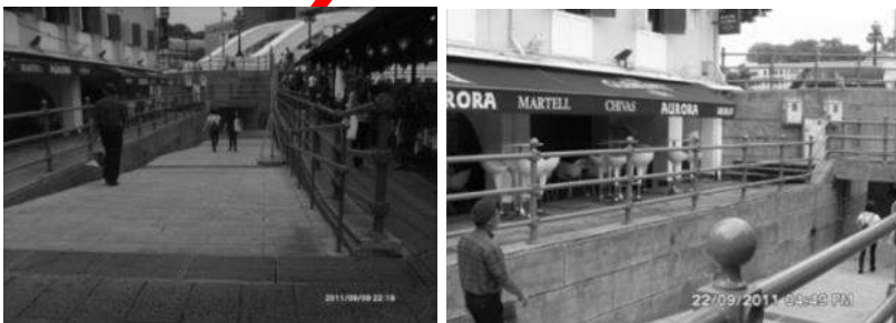
Gambar 6. Tangga dan jembatan yang menghubungkan Boat Quay dengan Elgin Bridge (South Bridge Road ) sumber: Dokumentasi Pribadi, 2011
