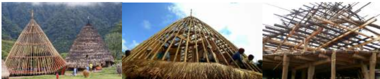
Gambar 6, 7, 8. Proses restorasi Mbaru Niang di Desa Waerebo, Flores (Sumber: https://bandanaku.wordpress.com , diakses 08 Mei 2017[6])
