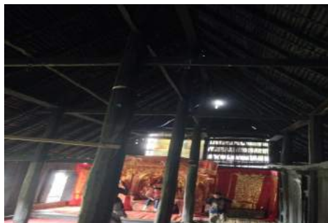
Gambar 4. Struktur rangka atap dan tiang-tiang di dalam Rumah Tuo Kampai Nan Panjang yang terlihat langsung karena tanpa penutup plafond
