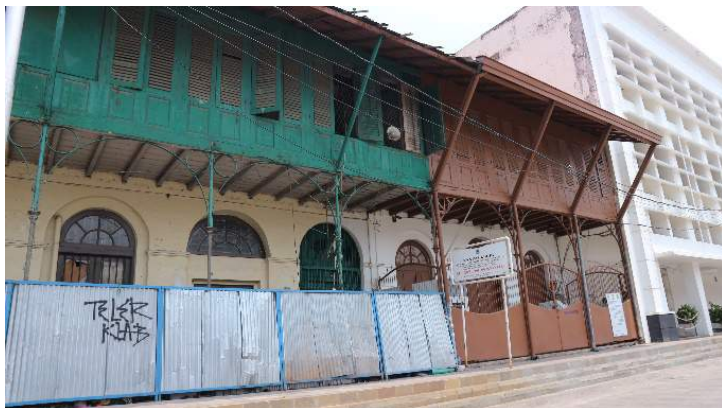
Gambar 9. Contoh Bangunan Konservasi di Kali Besar Sumber: Dokumentasi Pribadi, 2018
