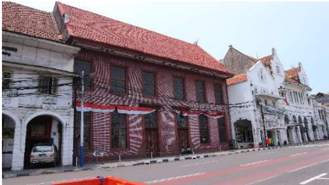
Gambar 8. Contoh Bangunan Konservasi di Kali Besar Sumber: Dokumentasi Pribadi, 2018
