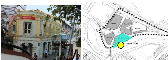
Gambar 40. Blok D Bagian Selatan Sumber: Dokumen Pribadi, 2018
