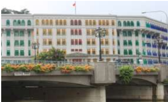
Gambar 47: MICA : Bangunan Ministry of Information, Communication and Arts di Hill Street, City Hall, tampak depan yang dipenuhi dengan deretan jendela-jendela disulap menjadi warna-warni yang cerah. Fungsi yang semula barak polisi dirubah, sehingga façade yang ada sekarang lebih mencerminkan fungsinya sebagai kantor MICA karena dari segi estetika terlihat lebih menarik, tidak memperlihatkan bangunan tua. Sumber: Dokumentasi Pribadi, 2012
