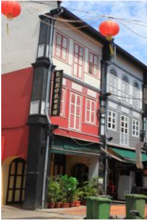
Gambar 43: Bangunan bergaya Etnis Cina di Singapura baik di kawasan permukiman Etnis Cina maupun di kawasan lainnya memiliki karakter khas Etnis Cina dengan konsep shop house nya. Namun saat ini bangunan-bangunan tersebut sudah beralih fungsi dari bangunan hunian dan toko menjadi bangunan komersial saja. Biasanya bangunan dikonversikan menjadi restoran, kafe, bar maupun pertokoan.
