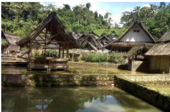
Gambar 9: Kawasan Permukiman Tradisional Kampung Naga, Tasikmalaya Kawasan lingkungan permukiman tradisional Kampung Naga di Tasikmalaya ini menjadi kawasan desa tradisional yang dikonservasi Sumber Gambar: Dokumen Pribadi, 2012
