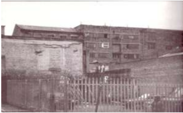
Gambar 1: Concert Square Sebelum Konversi: Kondisi bangunan tua Concert Square di Wood Street dalam area pusat perbelanjaan kota Liverpool sebelum dilaksanakan program konversi Sumber: http://www.urbansplash.co.uk/commercial/concert-square
