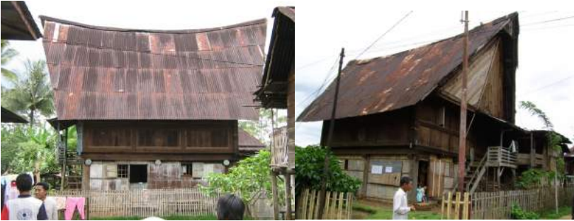
Gambar 82. Alih fungsi kolong rumah sebagai tempat tinggal (Sumber: Dokumentasi Pribadi, 2014)
