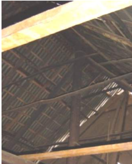
Gambar 62. Bagian atas ruang rumah tanpa plafond (Sumber: Dokumentasi Pribadi, 2014)
