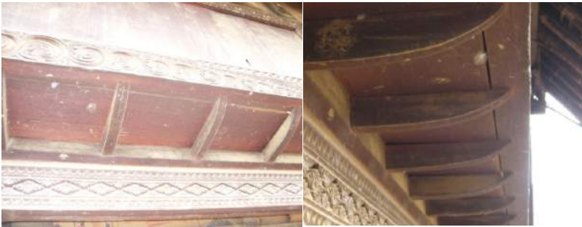
Gambar 57. Galar dengan panjang 30 cm (Sumber: Dokumentasi Pribadi, 2014)
