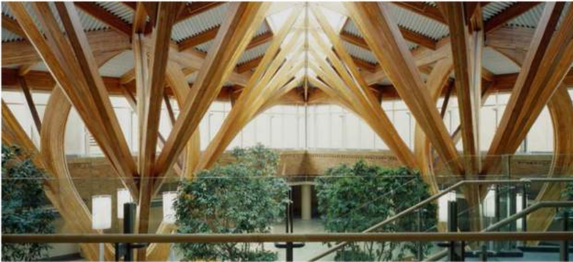
Gambar 31. Bentuk fleksibel dari struktur dengan kayu rekayasa (Sumber: Tjondro, 2014)
