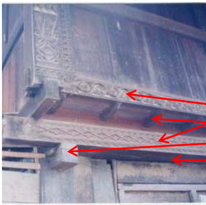
Gambar 54. Susunan Balok pada bagian bawah rumah (Sumber: Dokumentasi Pribadi, 2014)
