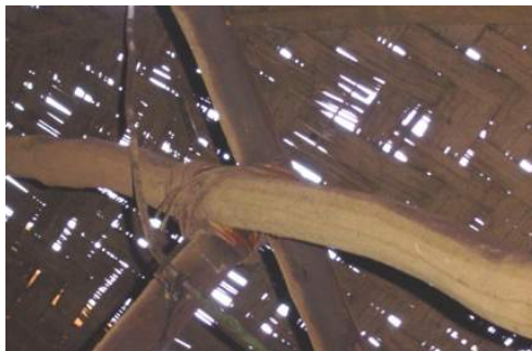
Gambar 74. Ikatan Uwi atau Rotan (Sumber: Dokumentasi Pribadi, 2014)
