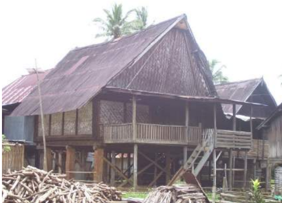
Gambar 47. Rumah Gilapan dinding bambu (Sumber: Dokumentasi Pribadi, 2014)
