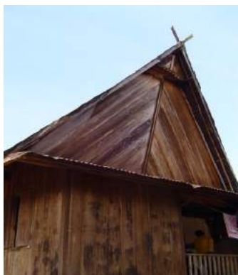
Gambar 76. Atap rumah Besemah yang khas (Sumber: Dokumentasi Penulis, 2014)
