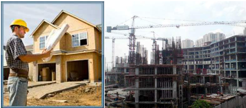
Gambar 1. Konstruksi bangunan rumah dan gedung
