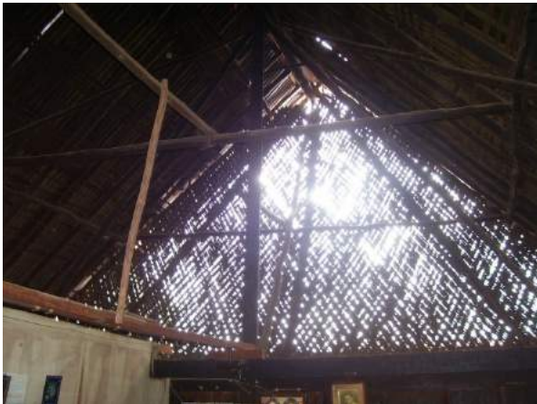
Gambar 68. Tampak Belayar dari dalam rumah (Sumber: Dokumentasi Pribadi, 2014)
