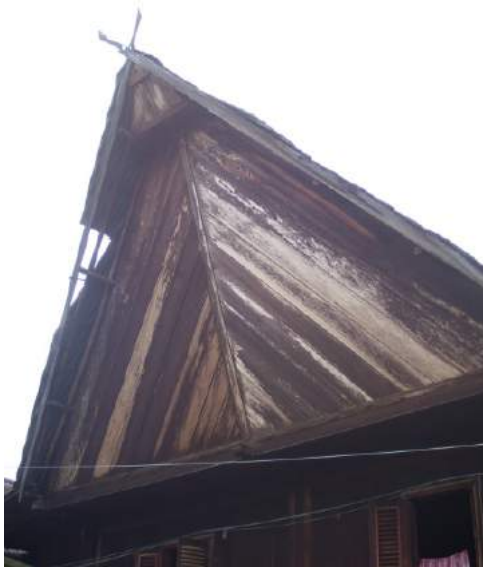
Gambar 66. Belayar yang terbuat dari kayu (Sumber: Dokumentasi Pribadi, 2014)
