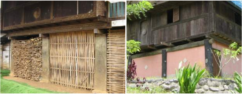
Gambar 51. Tiang modifikasi dari beton (Sumber: Dokumentasi Pribadi, 2014)
