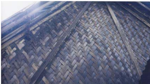
Gambar 67. Belayar berbahan rajutan bambu (Sumber: Dokumentasi Pribadi, 2014)
