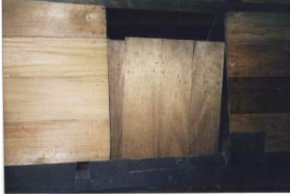
Gambar 65. Lubang pada Gelemat (Sumber: Dokumentasi Pribadi, 2014)
