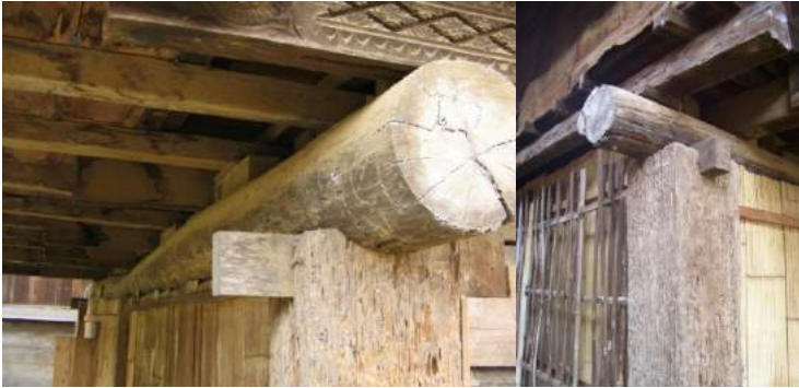
Gambar 55. Kitau bulat tanpa ukiran. (Sumber: Dokumentasi Pribadi, 2014)
