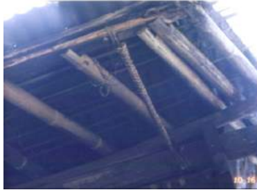
Gambar 73. Penggunaan Rotan sebagai penahan (Sumber: Dokumentasi Pribadi, 2014)
