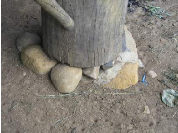
Gambar 50. Umpak Batu (Sumber: Dokumentasi Pribadi, 2014)
