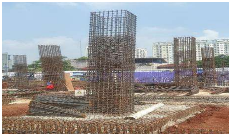
Gambar 4.14 Pekerjaan pembesian kolom
