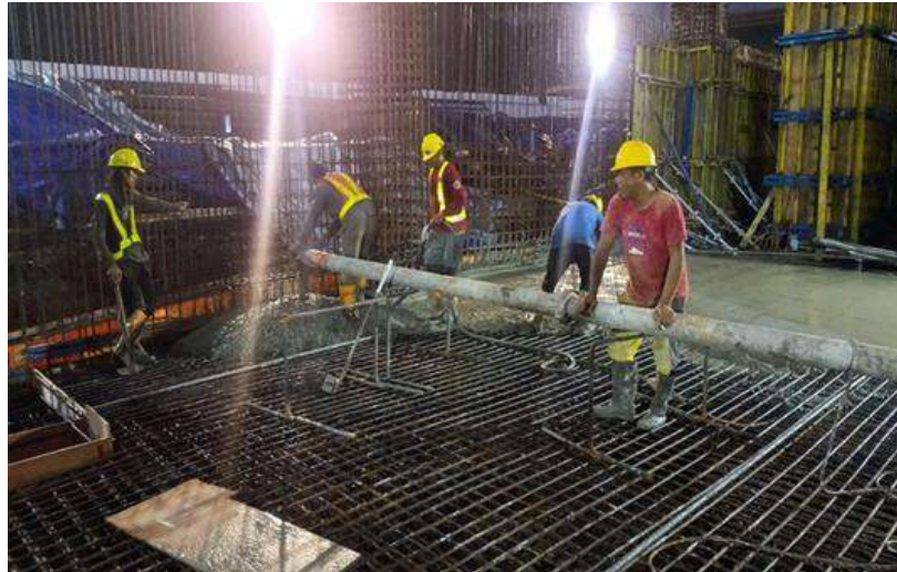
Gambar 4.22 Pekerjaan pengecoran balok dan plat lantai
