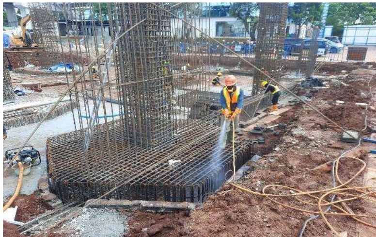
Gambar 4.10 Pekerjaan Penyemprotan Cairan Anti Rayap
