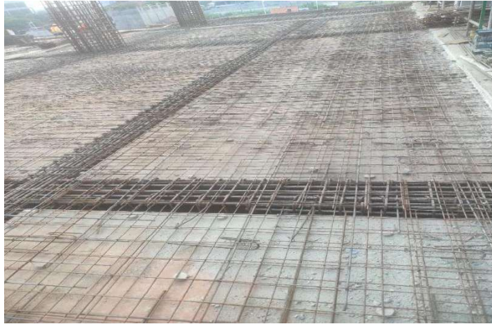
Gambar 4.21 Pekerjaan penulangan balok dan plat lantai
