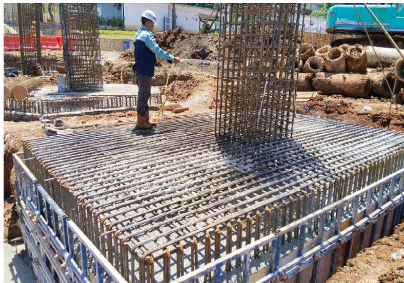
Gambar 4.13 Pekerjaan curing beton pile cap
