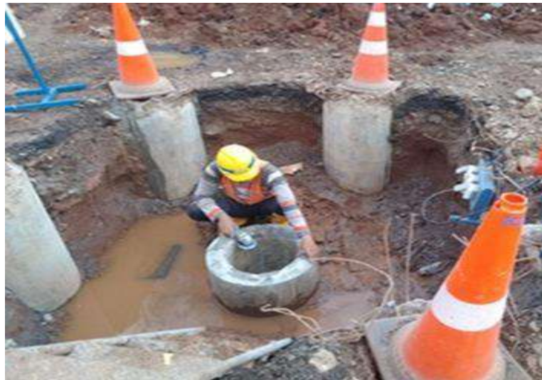
Gambar 4.8 Pekerjaan Pemotongan Kepala Tiang Pancang
