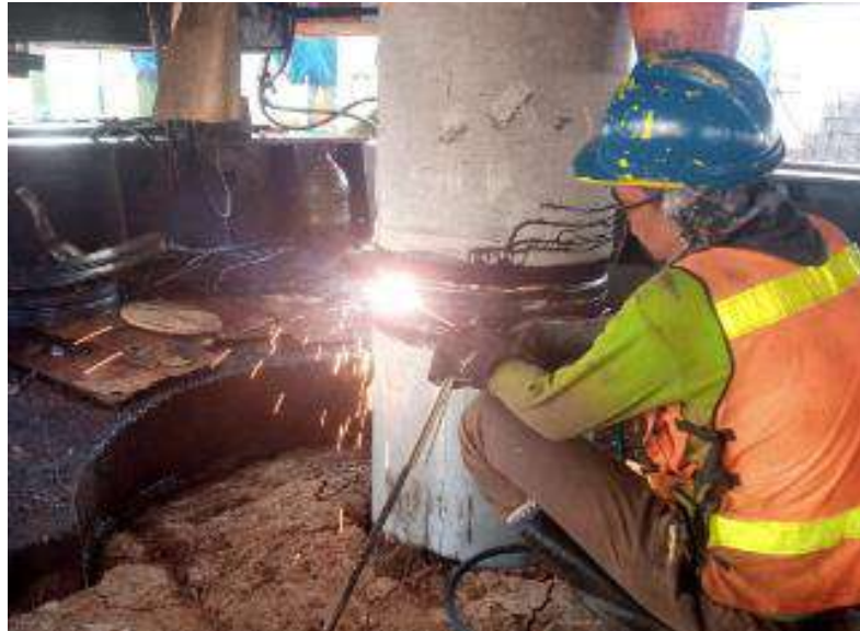
Gambar 4.6 Pekerjaan penyambungan tiang pancang
