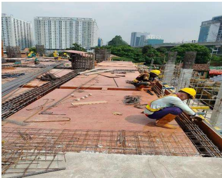
Gambar 4.20 Pekerjaan Pemasangan Multiplek
