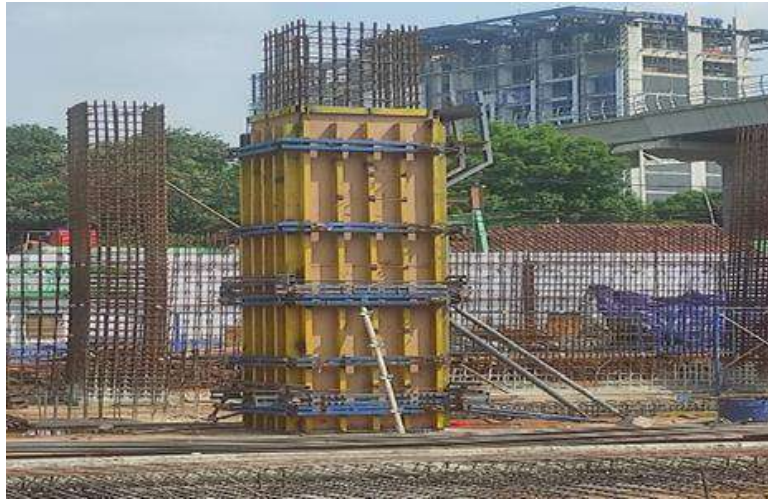
Gambar 4.15 Pekerjaan bekisting
