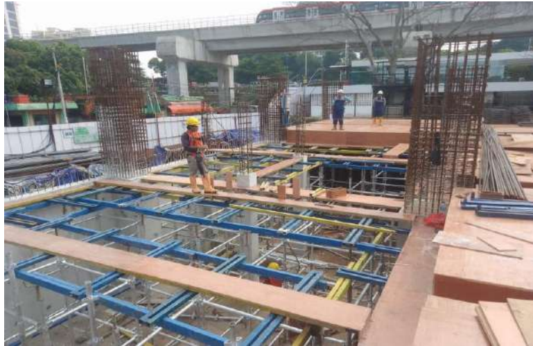
Gambar 4.19 Pekerjaan pemasangan perancah dan bekisting plat lantai
