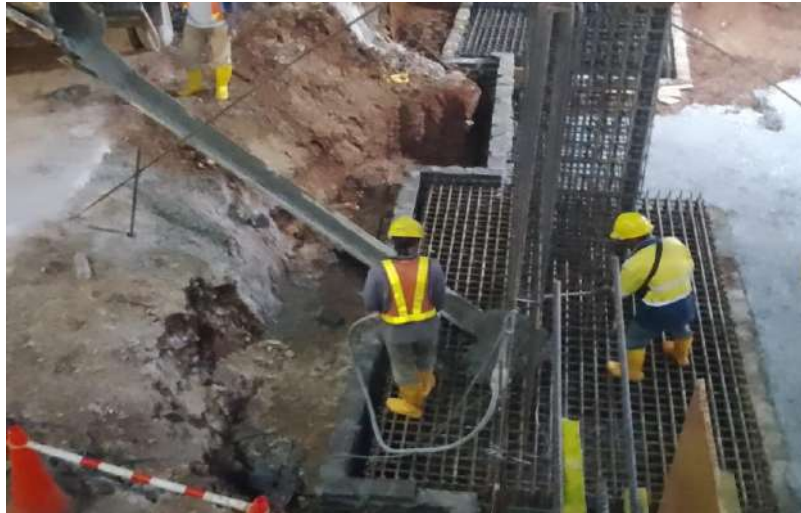
Gambar 4.12 Pekerjaan pengecoran pile cap
