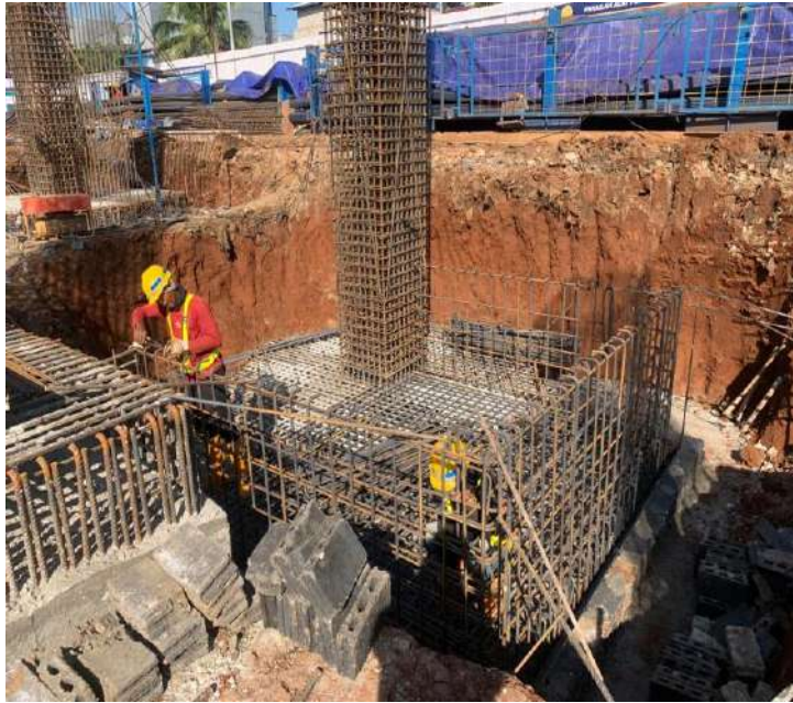
Gambar 4.11 Pekerjaan pembesian pile cap
