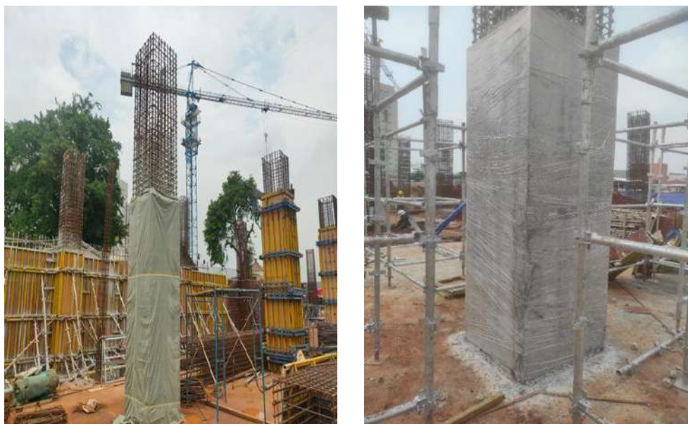
Gambar 4.18 Pekerjaan curing beton dengan plastik wrap dan terpal
