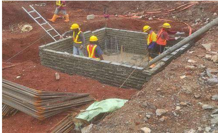
Gambar 4.9 Pekerjaan Pemasangan Bekisting Pile Cap
