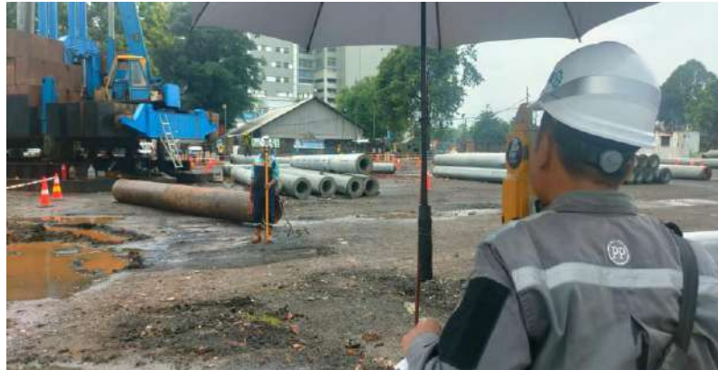
Gambar 4.4 Pekerjaan Marking out titik tiang pancang
