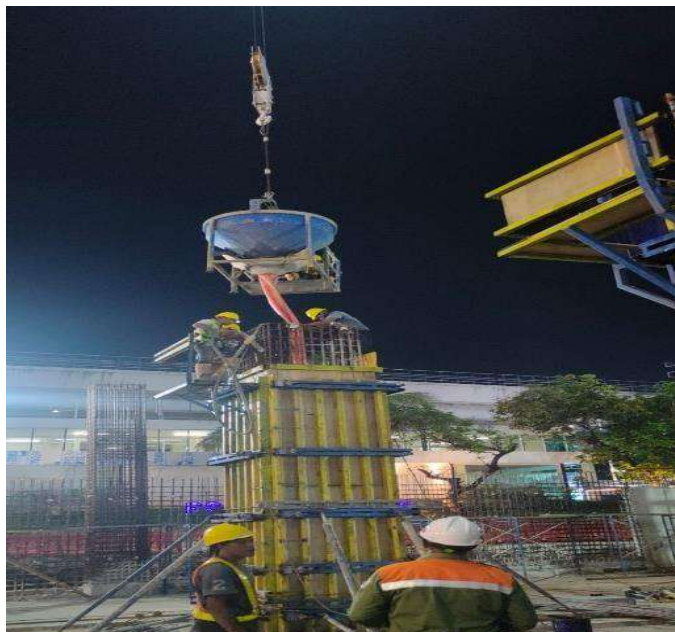
Gambar 4.16 Pekerjaan Pengecoran Kolom
