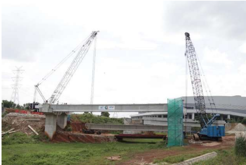
Gambar 2.5 Erection girder menggunakan crane
