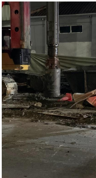
Gambar 4. 12 Pembersihan dasar lubang
