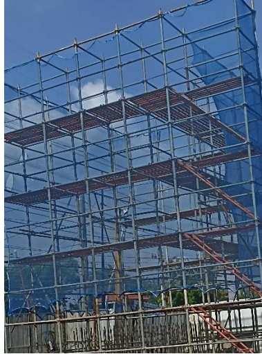
Gambar 4. 25 Pemasangan scaffolding
