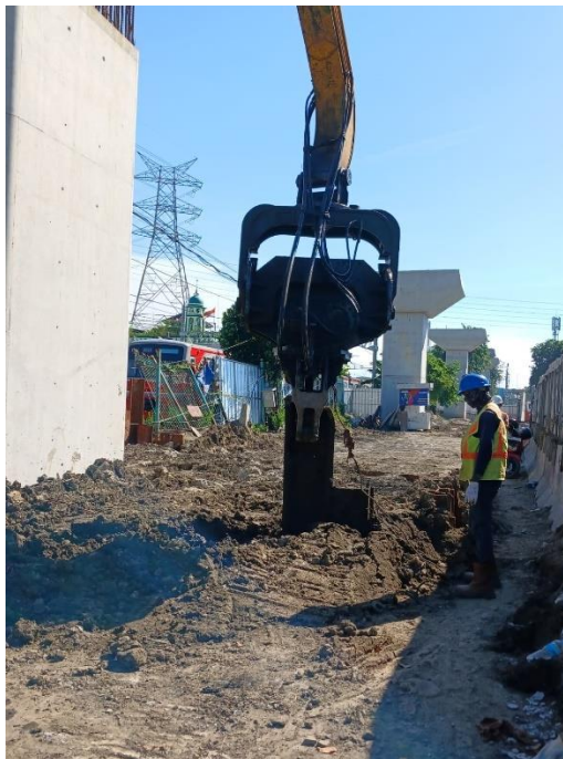
Gambar 4. 22 Pencabutan sheet pile
