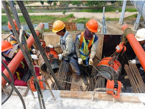
Gambar 4. 39 Pemasangan hydraulic jack
