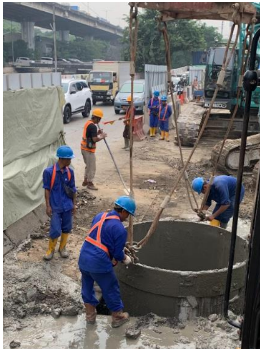
Gambar 4. 16 Pencabutan casing
