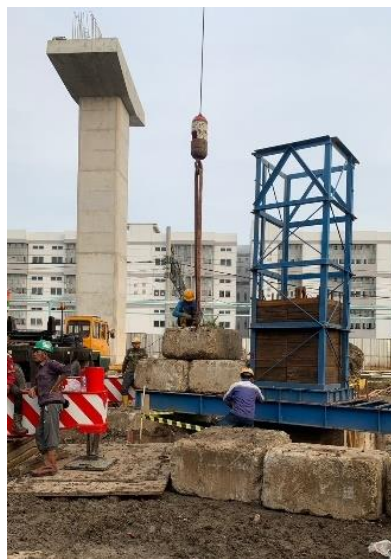
Gambar 5. 1 Persiapan pengujian PDA test
