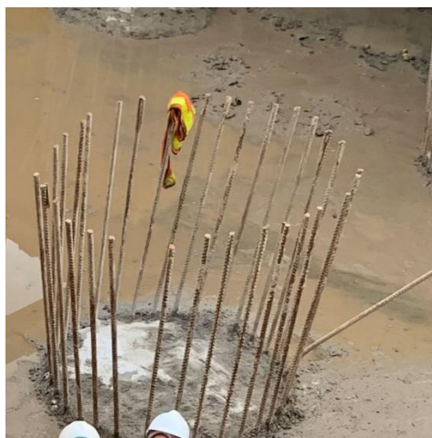
Gambar 5. 3 Persiapan pengujian PIT test
