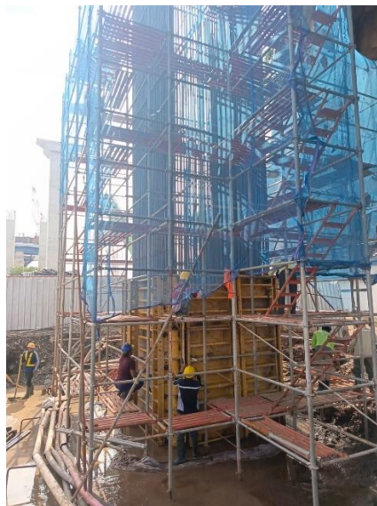
Gambar 4. 26 Fabrikasi tulangan pier
