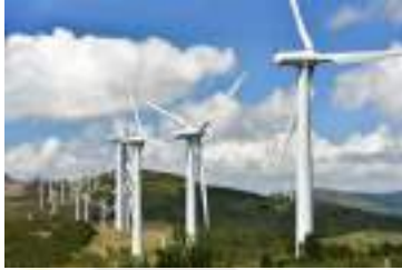
Gambar 11. Pembangkit Listrik Tenaga Angin
