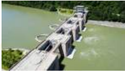
Gambar 10. Pembangkit Listrik Tenaga Air
