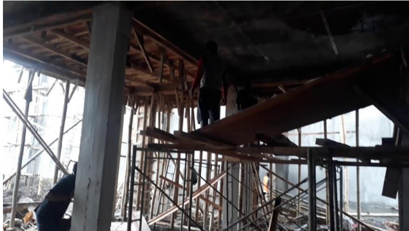
Gambar 4.48. Pembongkaran Bekisting Balok dan Plat
