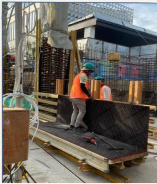
Gambar 4.39. Pemasangan Bekisting Kolom
