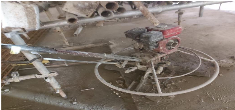
Gambar 4. 13 Mesin Trowel
