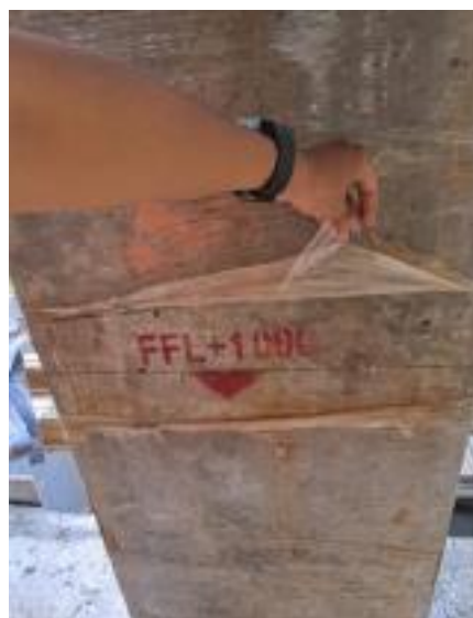
Gambar 4.42. Perawatan Beton Kolom
