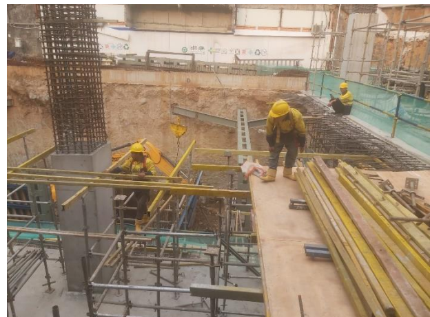
Gambar 4.43. Pekerjaan Pembekistingan Plat
