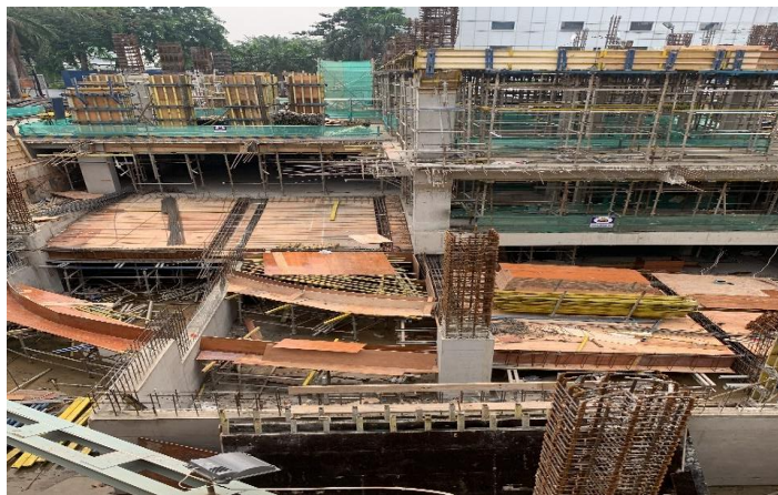
Gambar 1.4 Kondisi Proyek Pada Saat Selesai KP Lantai 1
