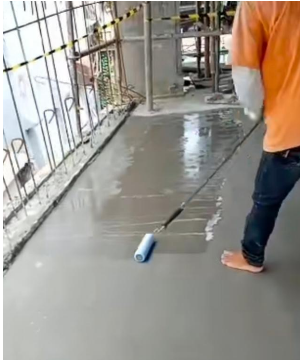
Gambar 4.49. Perawatan Beton Plat dan Balok
