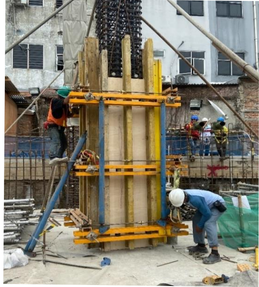
Gambar 4.39. Pemasangan Bekisting Kolom
