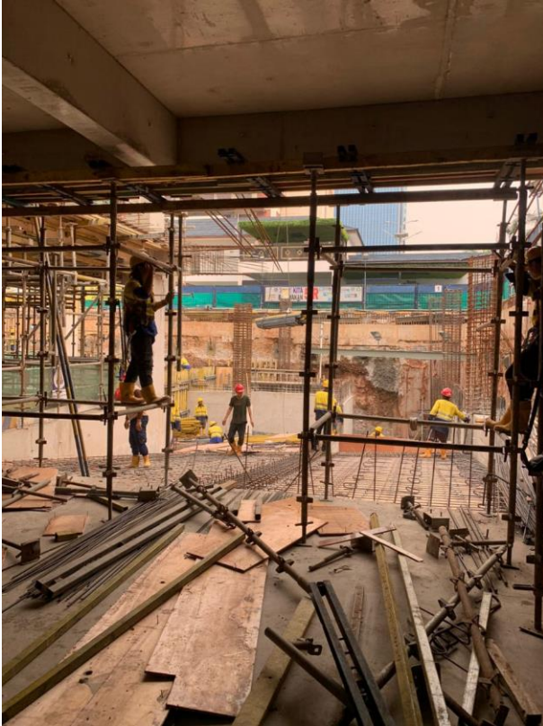
Gambar 4.45. Pekerjaan Pembesian Plat
