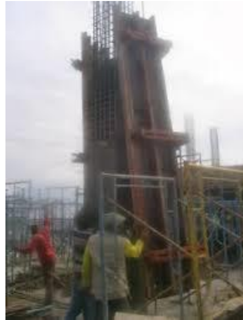
Gambar 4.41. Pekerjaan Pembongkarn Bekisting Kolom
