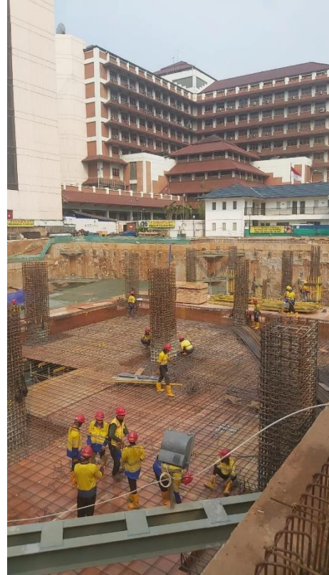
Gambar 4.45. Pekerjaan Pembesian Plat
