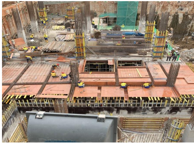
Gambar 1.3 Kondisi Proyek Pada Saat Memulai KP pada basement 2
