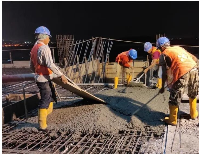
Gambar 4.46. Pekerjaan Pengecoran Plat Lantai
