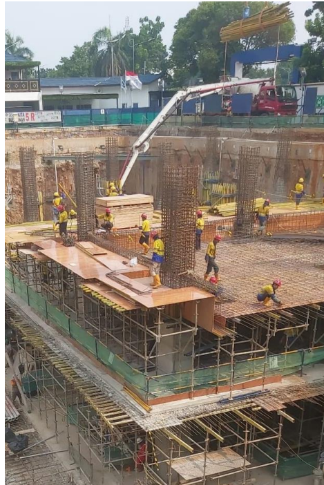
Gambar 4.44. Pekerjaan Pembesian Balok
