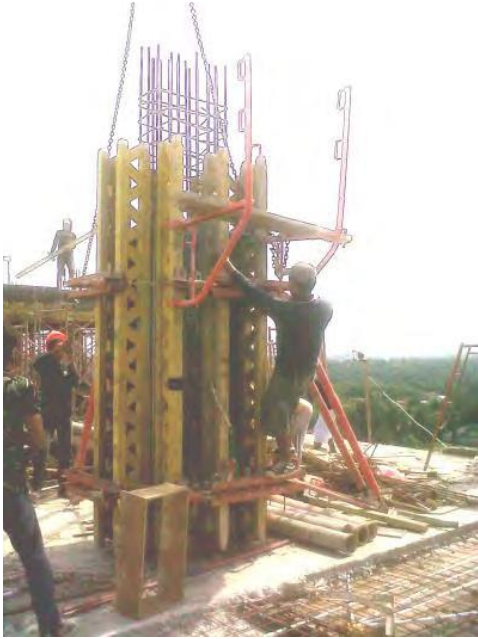
Gambar 4.41. Pekerjaan Pembongkarn Bekisting Kolom
