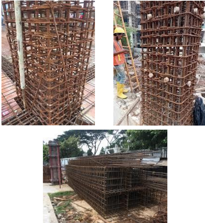
Gambar 4.38. Pekerjaan Pembesian Kolom
