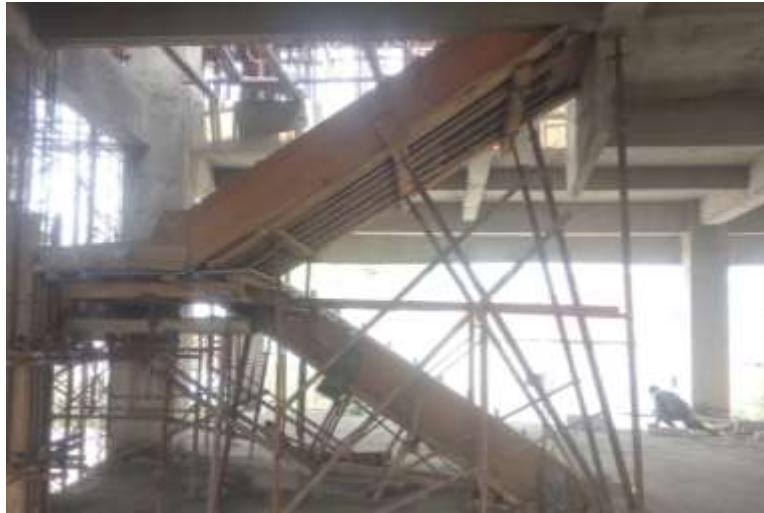
Gambar 4.13 Scaffolding yang digunakan pada pekerjaan tangga
