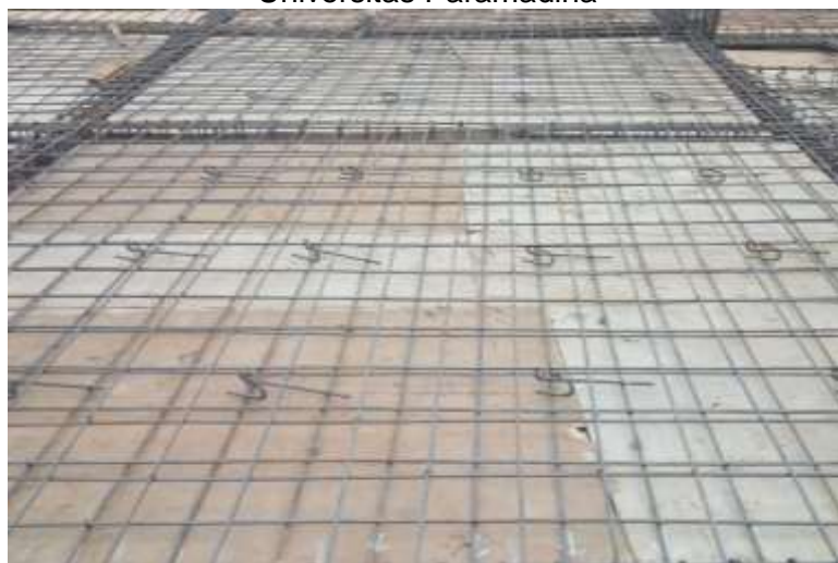
Gambar 4.10 Detail tulangan plat pada proyek pembangunan Gedung Universitas Paramadina
