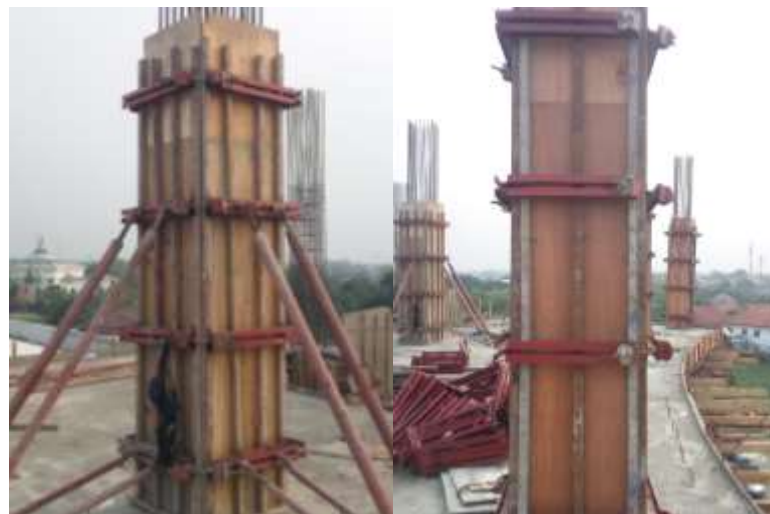
Gambar 4.4 Hasil pekerjaan bekisting kolom
