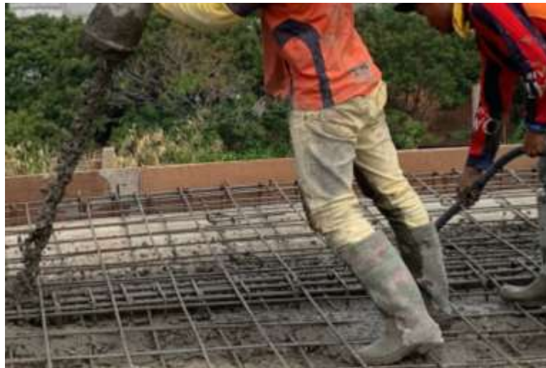
Gambar 4.12 Proses pekerjaan pengecoran plat dan balok
