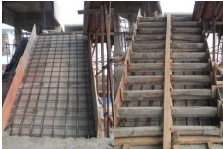
Gambar 4.14 Pekerjaan bekisting dan penulangan pada pekerjaan tangga
