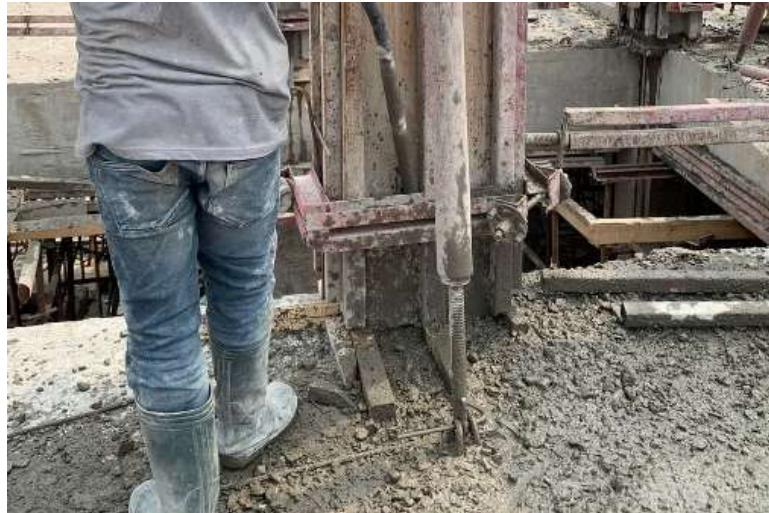
Gambar 4.5 Proses pekerjaan pepadatan pengecoran kolom dengan vibrator
