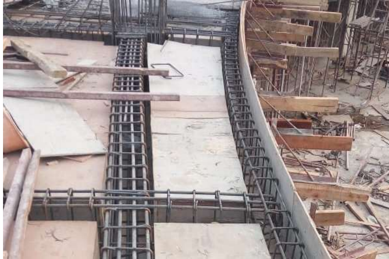
Gambar 4.7 Pekerjaan bekisting balok
