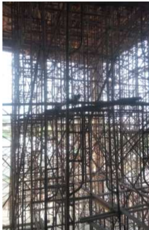
(Sumber: Dokumentasi, 2023) Gambar 4.27 Scaffolding
