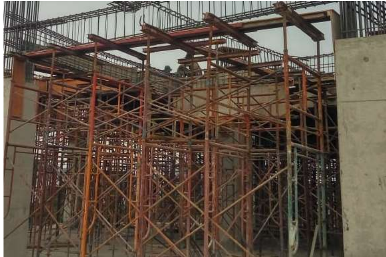
Gambar 4.6 Scaffolding yang digunakan pada pekerjaan balok
