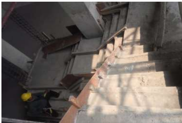
Gambar 4.15 Pekerjaan tangga setelah dilakukan pengecoran
