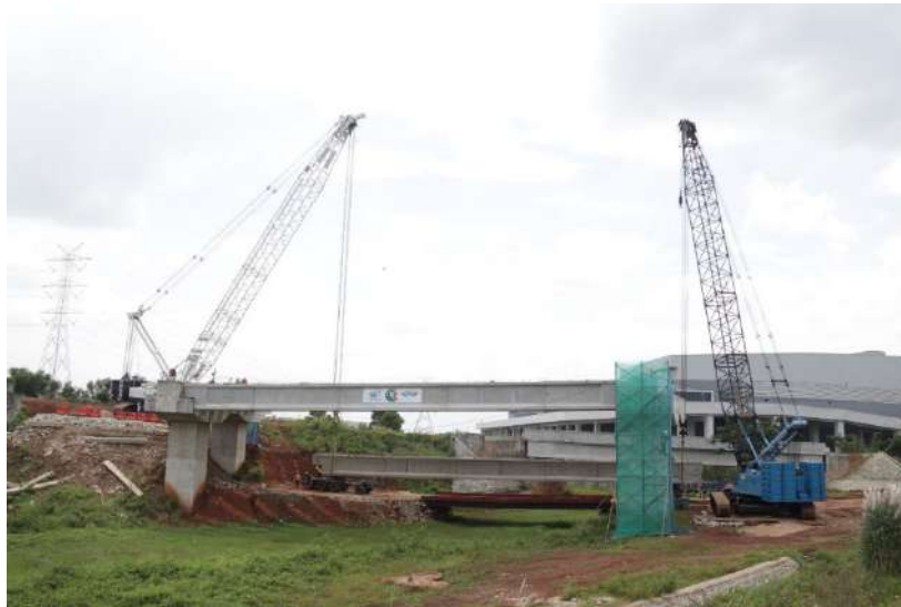
Gambar 2.5 Erection girder menggunakan crane Sumber: PT. Waskita Beton Precast Tbk. (2023)
