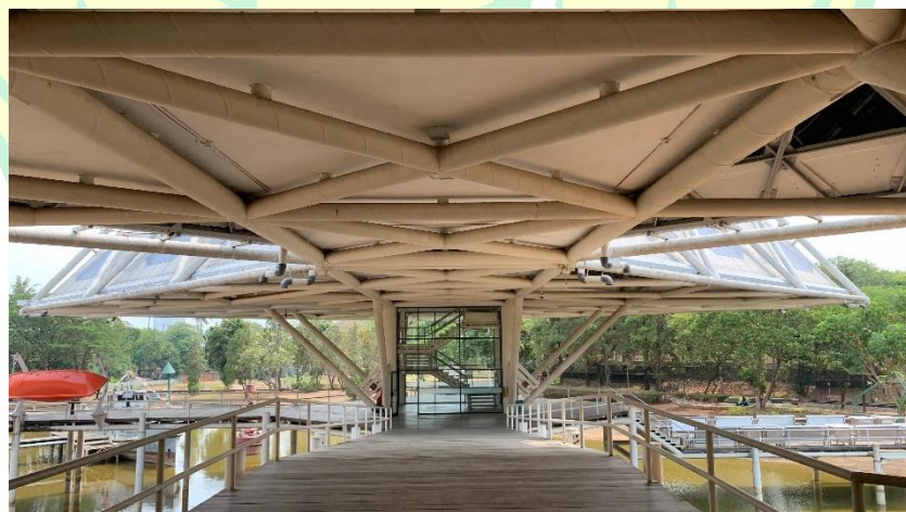
Gambar 32 : Foto Struktur Baja Tubular dan Rangka Ruang. Sumber Gambar : Data Pribadi, 2023
