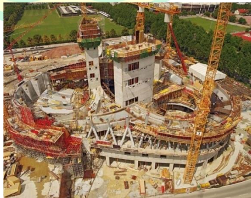
Gambar 15 : Proses Konstruksi dari Mercedes-Benz Museum. Sumber Gambar : PERI, t.thn
