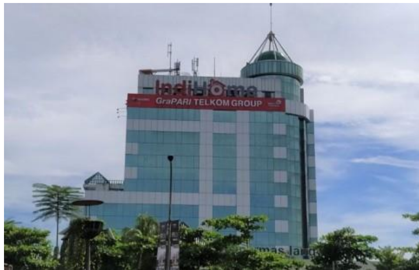
Gambar 4.1 Gedung PT. Telkom Indonesia WITEL Tangerang
