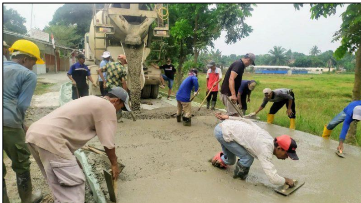
Gambar 4.2.4 Proses Pengecoran Betonisasi Sumber : Detak Media.com
