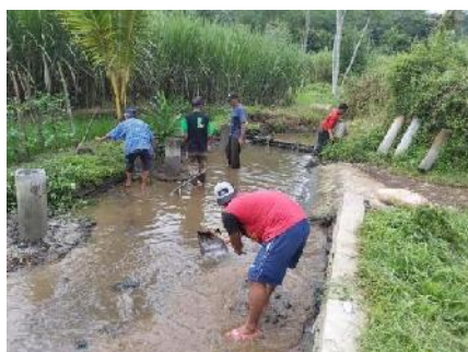
Gambar 5. Pembangunan drainase (kanan)
