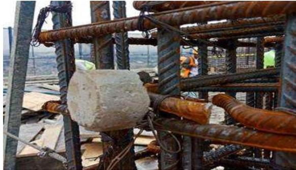
Gambar 4.19 Pemasangan beton *decking*
