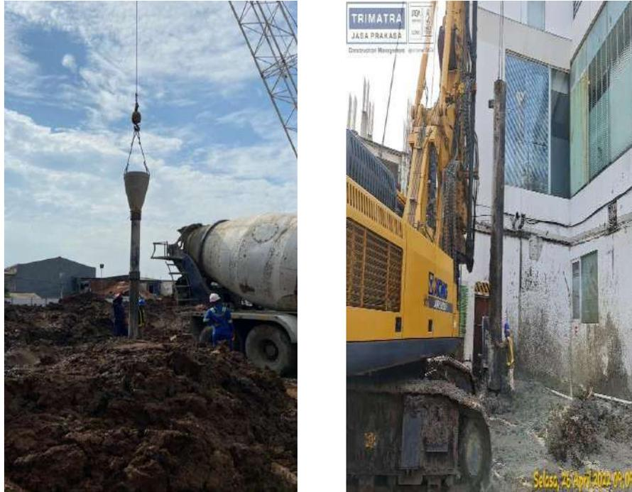
Gambar 4.6 Pelepasan Casing
