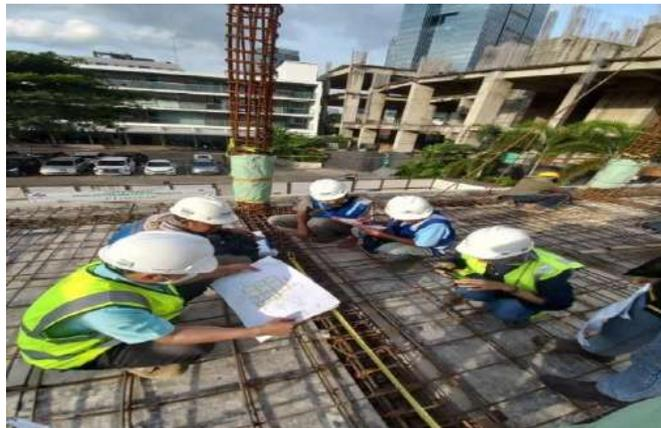
Gambar 5.11 Inspeksi pekerjaan sebelum pengecoran
