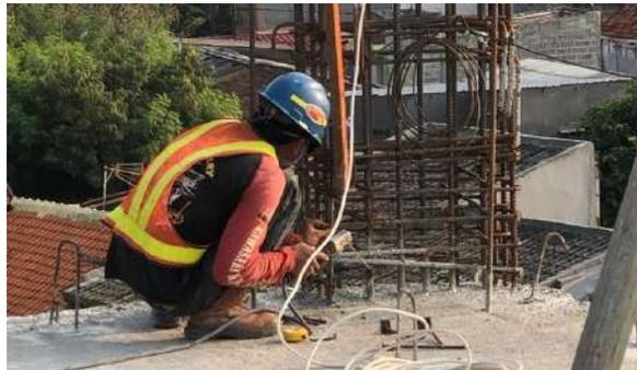
Gambar 4.20 Pemasangan sepatu kolom
