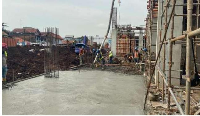
Gambar 4.28 Penyaluran beton *readymix* ke area cor
