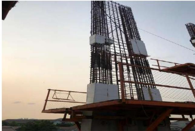
Gambar 4.30 Rangkaian pembesian *shear wall*
