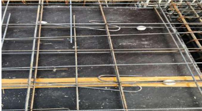
Gambar 4.28 Beton decking dan tulangan pembatas
