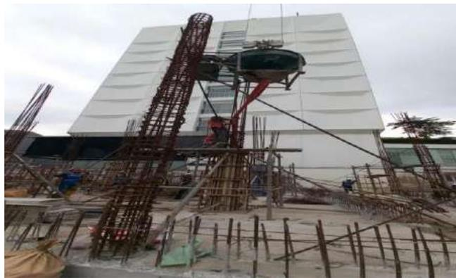
Gambar 4.23 Pengecoran kolom
