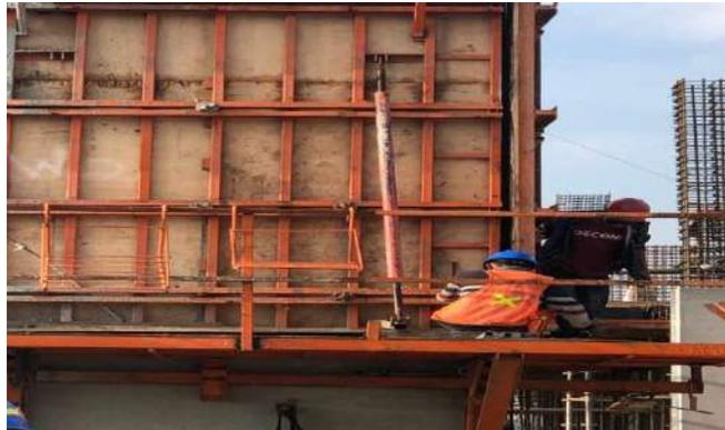
Gambar 4.34 Pembongkaran bekisting *shear wall*
