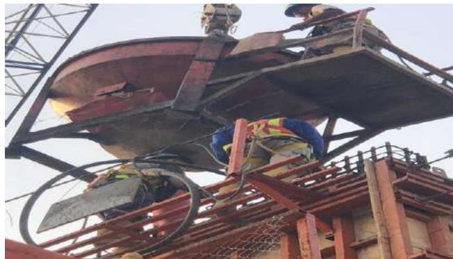
Gambar 4.33 Pengecoran *shear wall*
