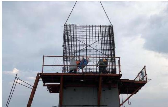
Gambar 4.31 Rangkaian tulangan besi diangkat dengan *tower crane*
