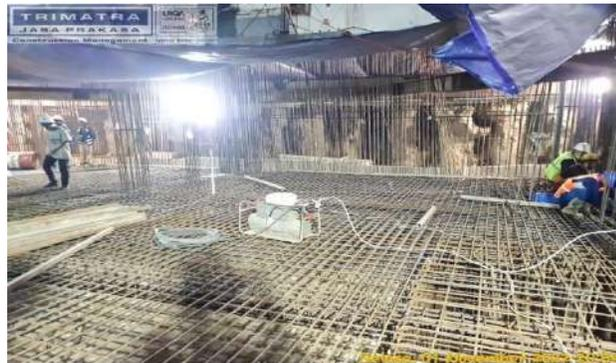
Gambar 4.12 Pembesian *pile cap*
