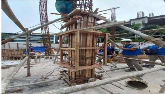
Gambar 4.21 Pemasangan bekisting kolom
