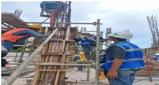
Gambar 4.22 Vertikalisasi bekisting kolom
