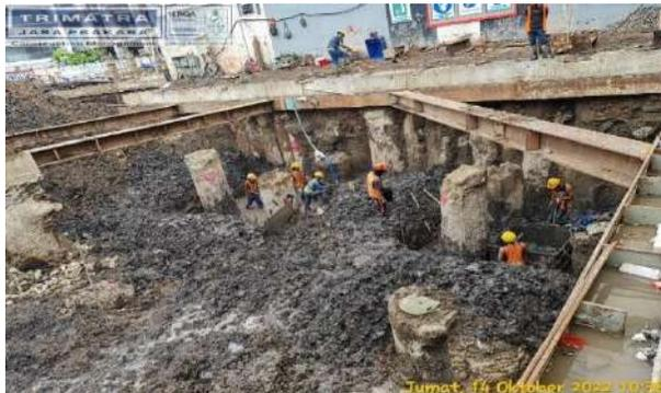
Gambar 4.9 Pemotongan kepala *bored pile*
