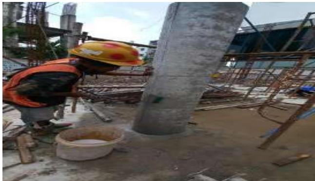
Gambar 4.29 Perawatan beton dengan air
