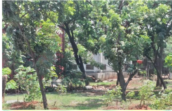
Gambar 2.36 Gardu Listrik dan Ruang Genset PT. KBN Marunda (Sumber : Pribadi)
