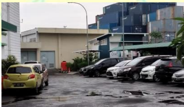
Gambar 2.3 Gardu Listrik dan Ruang Genset Kantor Pusat PT. KBN
