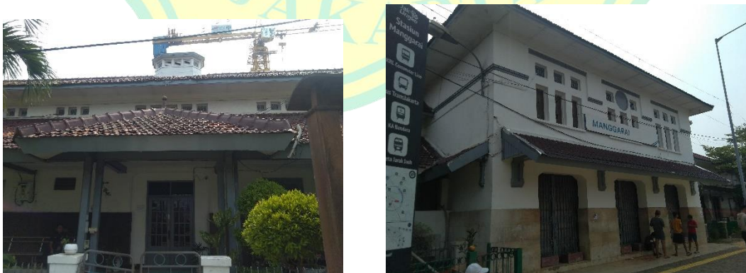
Gambar 2.15 fasad Stasiun Manggarai
