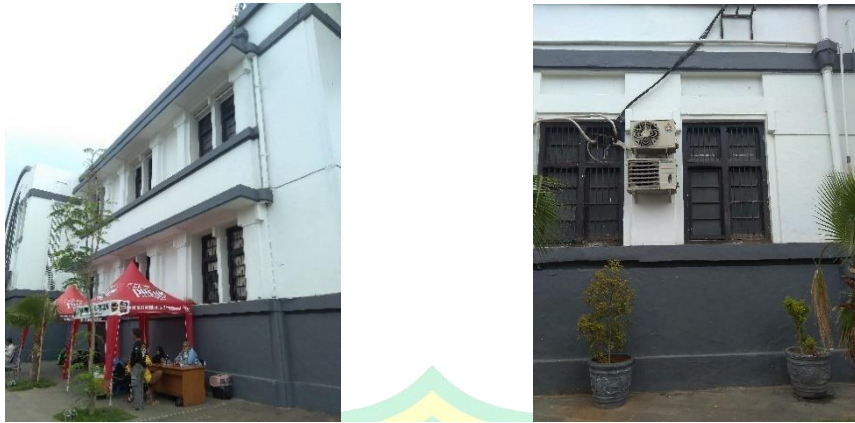
Gambar 2.7 jendela Stasiun Jakarta Kota
