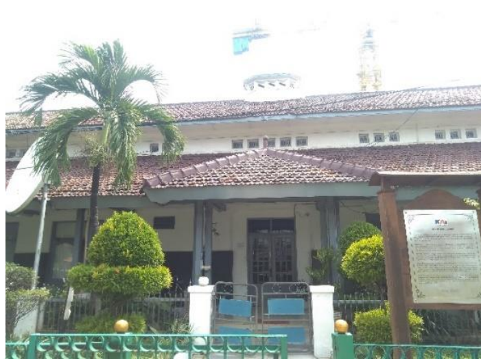
Gambar 2.11 fasad Stasiun Manggarai
