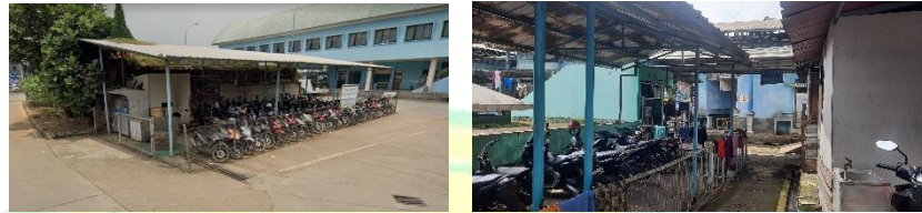
Gambar 3.9 Penitipan Motor dan Toilet Terminal Bus Cileungsi
