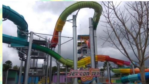
Gambar 4.22 Rangka Baja Penompang Wahana Seluncuran
