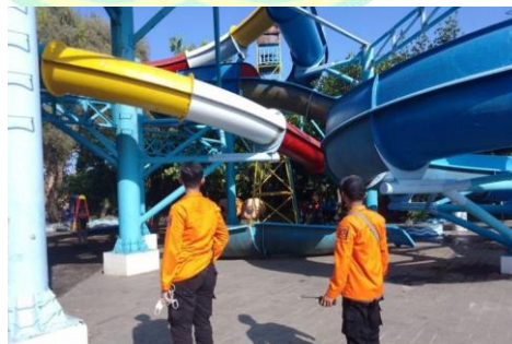
Gambar 4.23 Rangka Baja Penompang Wahana Seluncuran
