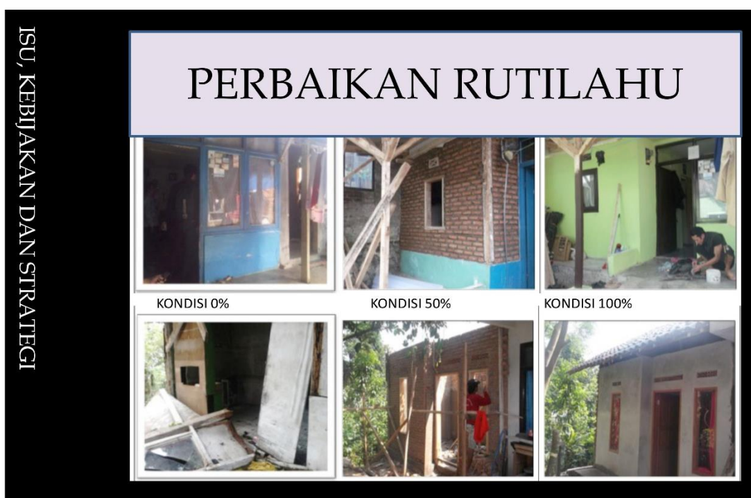
Gambar 6. 10 Kondisi Perbaikan Rutilahu Kota Bandung
