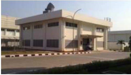
Gambar 2 Gedung utility / rumah pembangkit.
